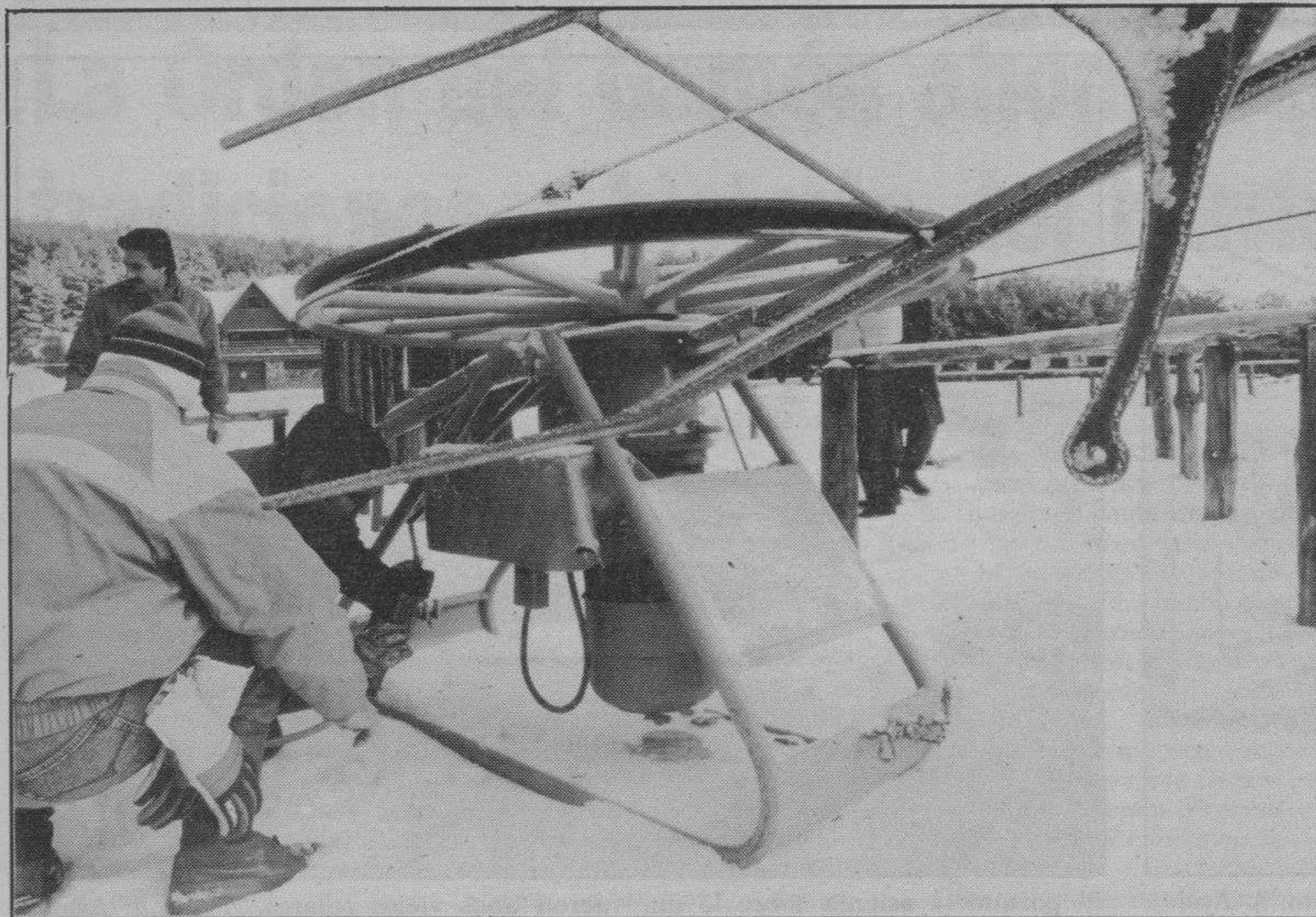
El tele-baby de la estación de esquí estaba ayer totalmente reparado. (Foto J.J. Matías).
