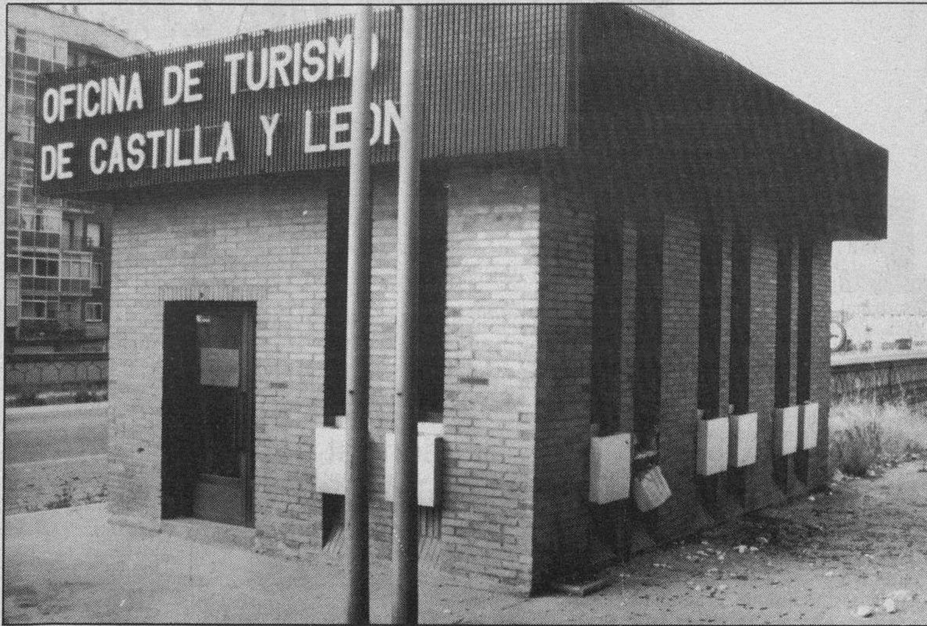
La explosión produjo la rotura de todos los cristales de la oficina. (Foto: E. Truchuelo).
