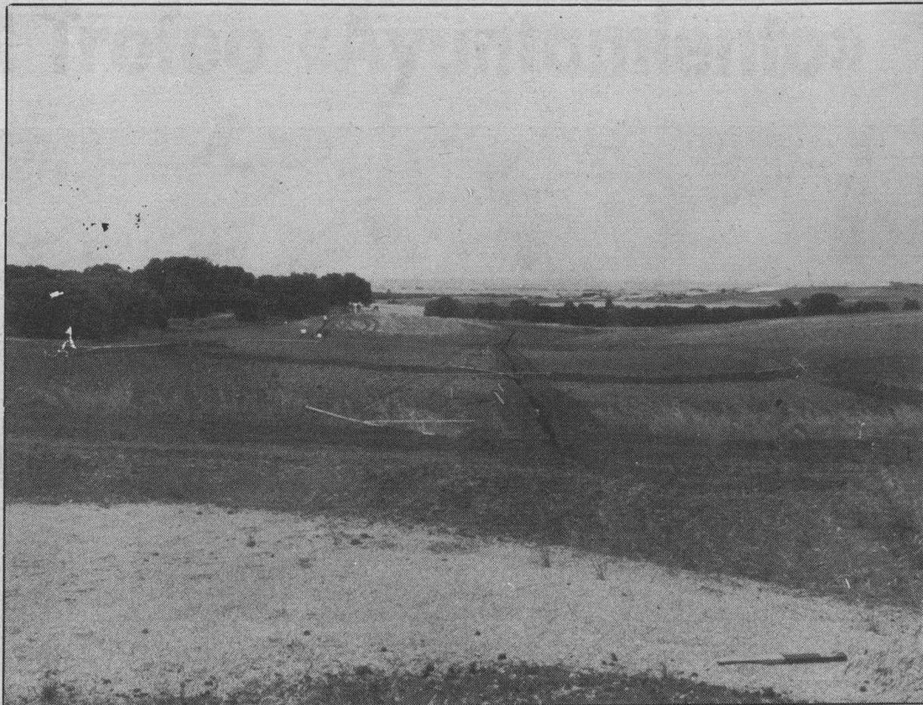
Un momento en el que se están metiendo los tubos para el regadío. (Foto: Luis).
