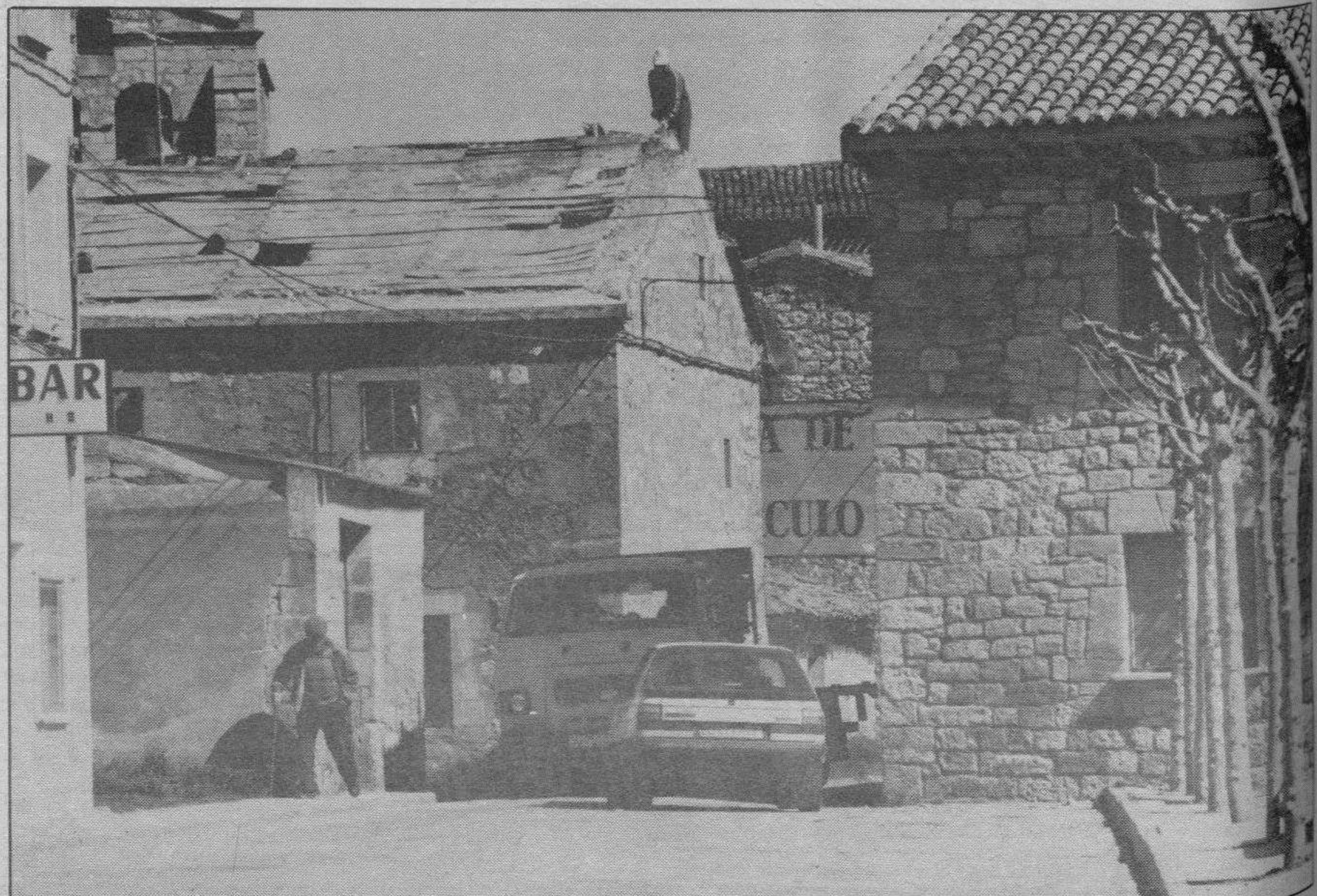
Estrechamiento peligroso de la carretera de Poza a su paso por el barrio de Villimar. Foto L. Matías
