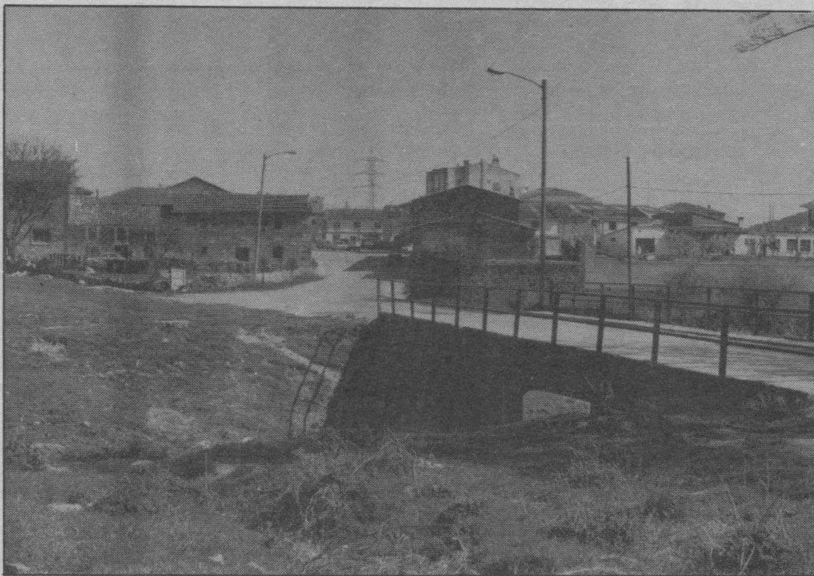
El puente sobre el río Vena es la entrada al barrio de Villímar. Foto L. Matías
