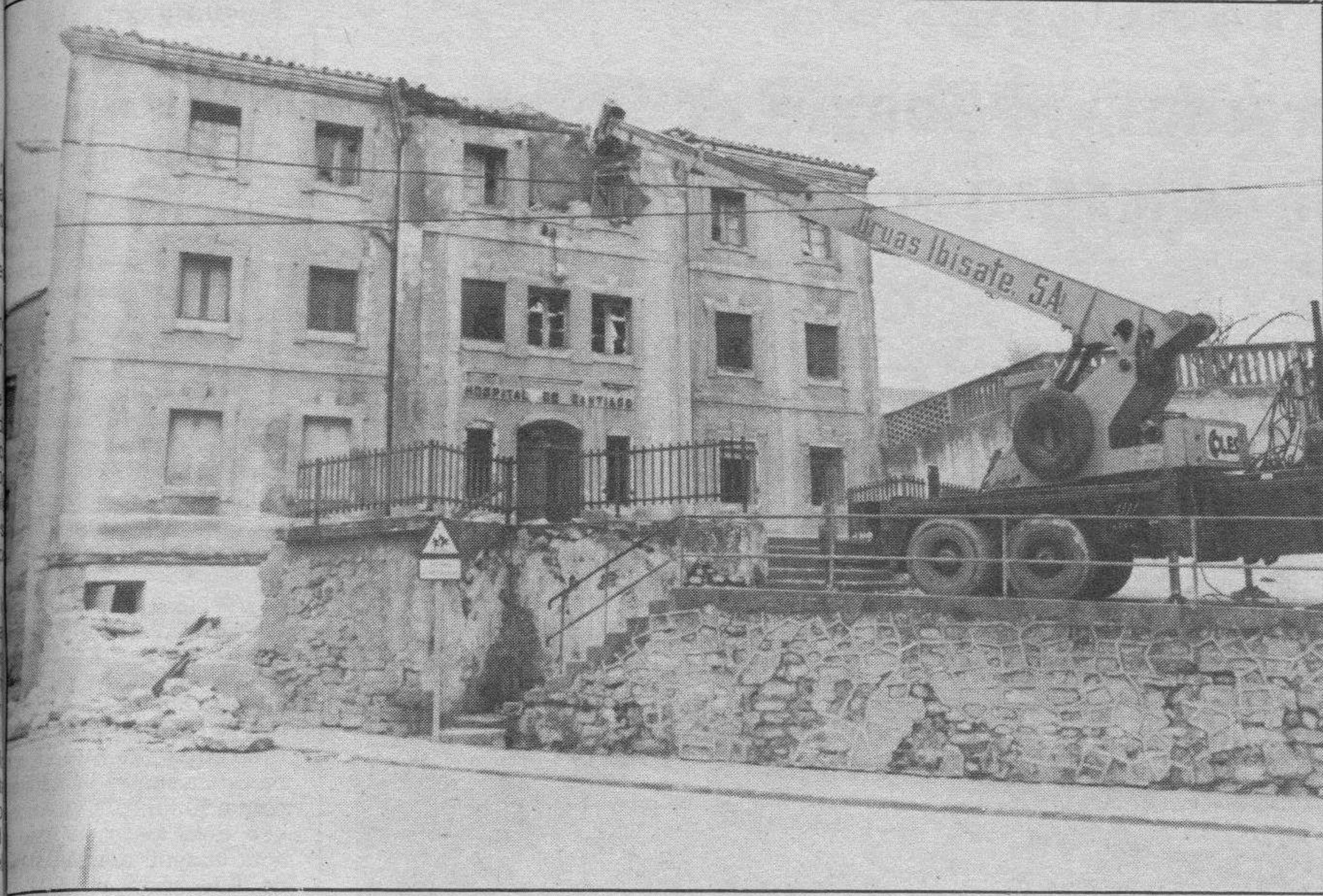
La grúa empezó la demolición sobre las nueve de la mañana, con el derribo se va parte de la historia mirandesa. F. Truchuelo
