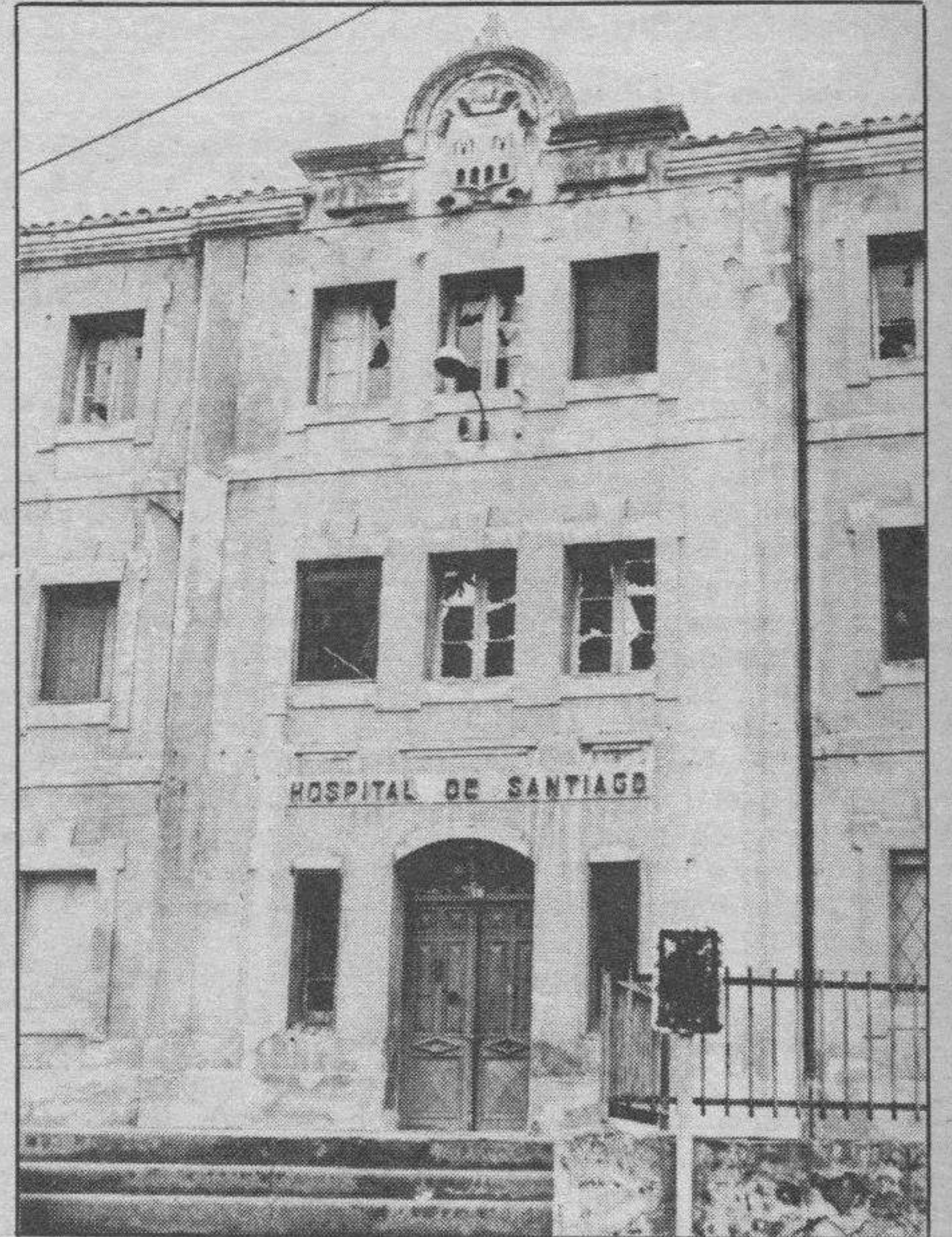
Horas antes del derribo así estaba la fachada. F. Truchuelo
