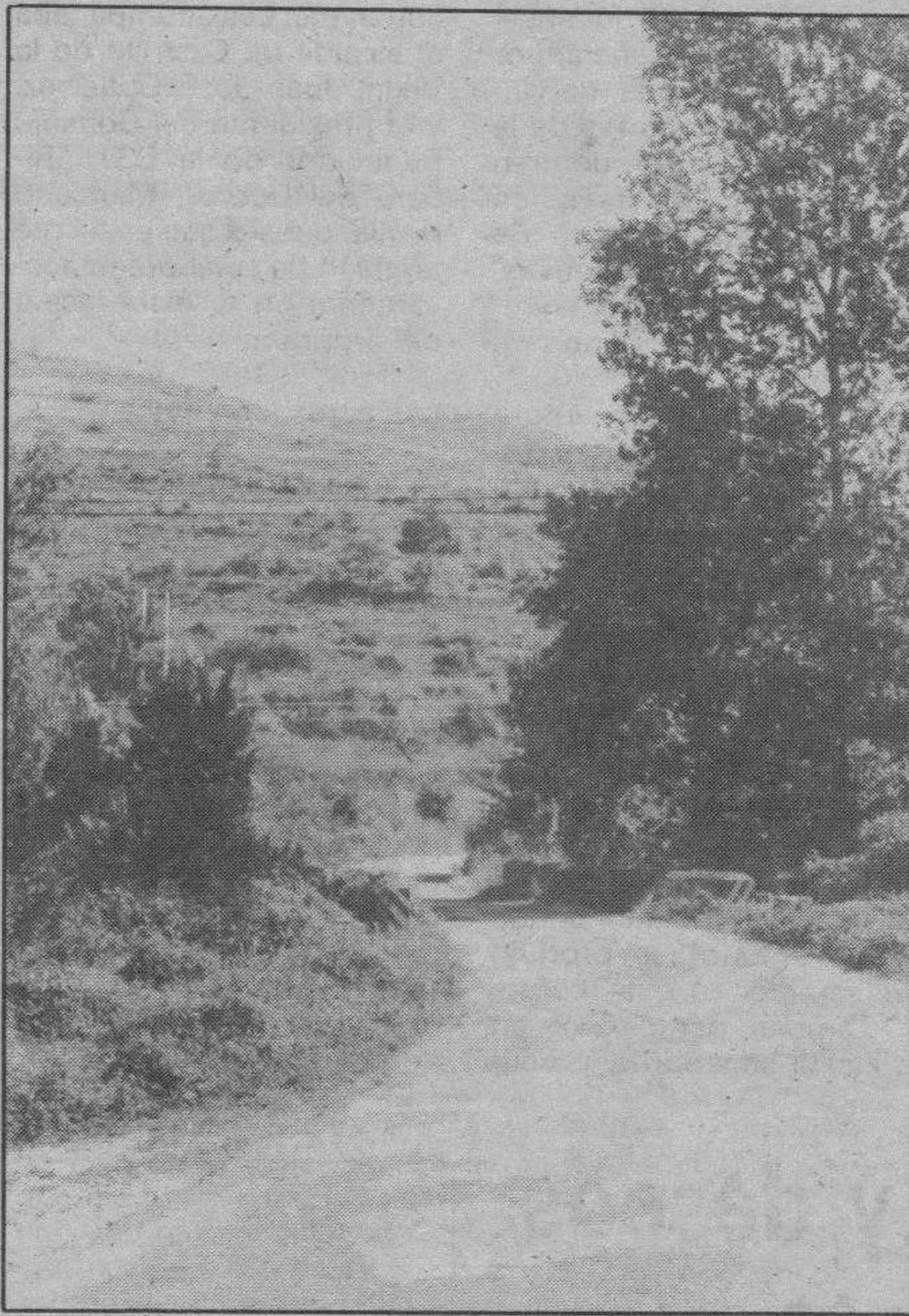
Carretera Covanera-Masa por Sedano. Puente sobre el río «Sedanillo»
