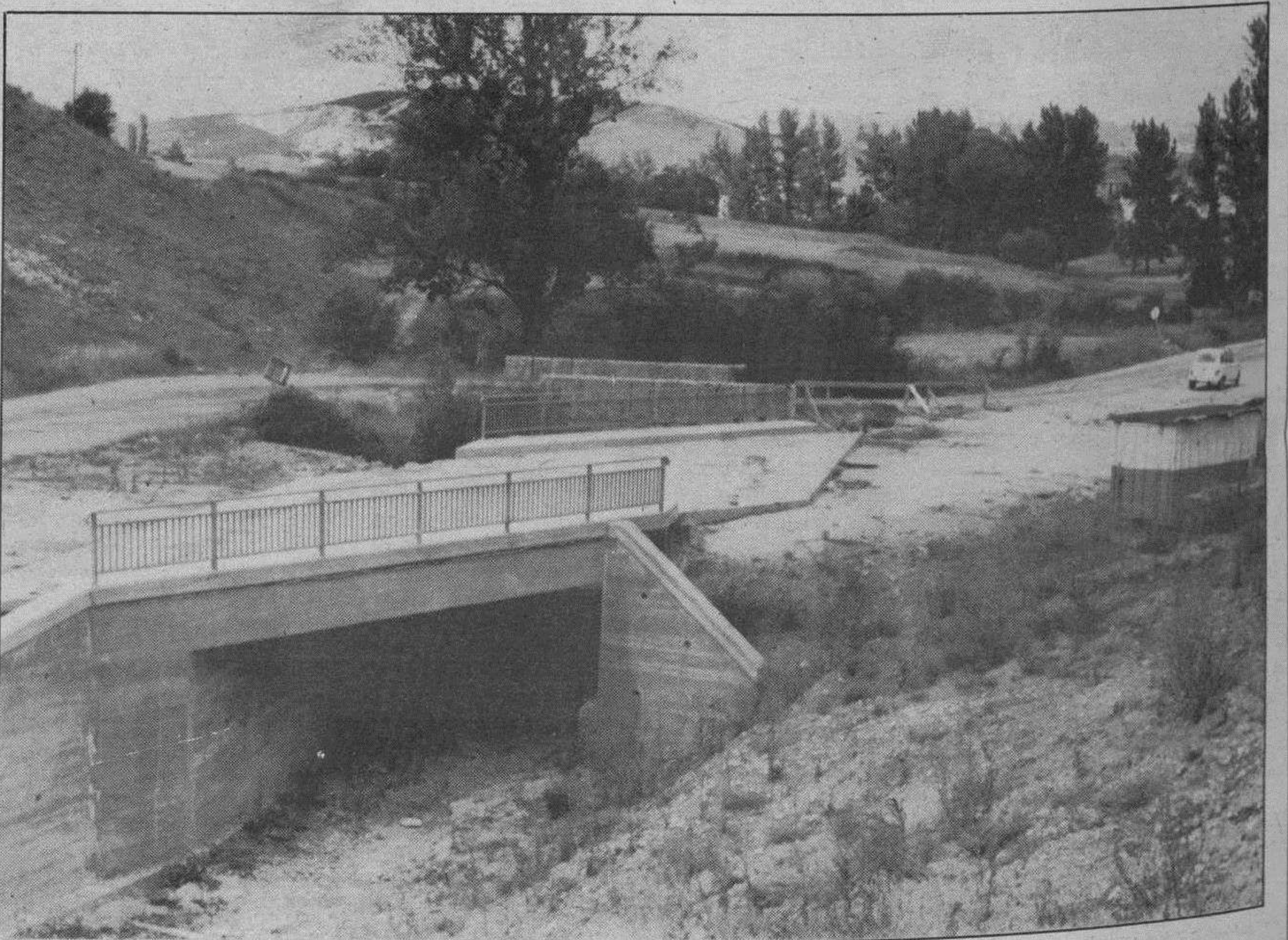
Puente nuevo sin terminar sobre el Hormazuela junto a Coclina.
