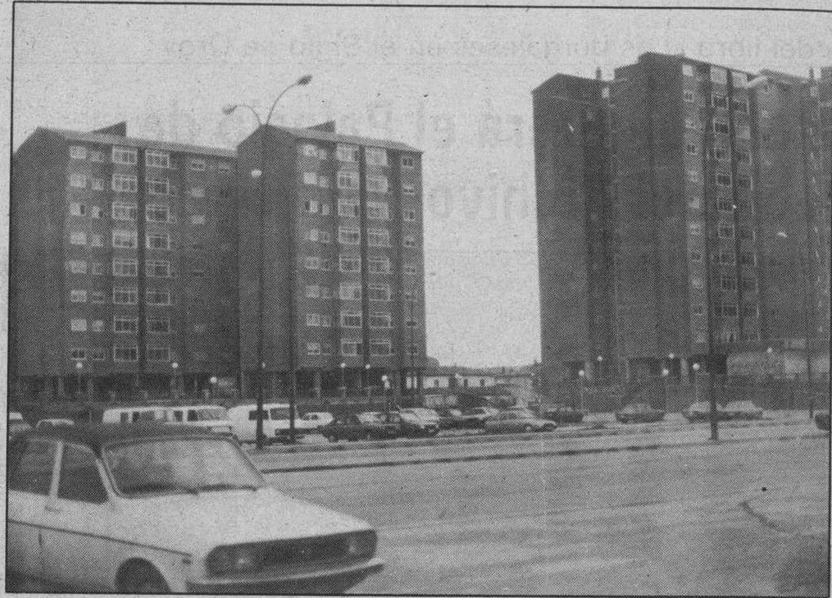
Las obras en las viviendas de la zona de San Juan de los Lagos tienen un presupuesto de 26 millones de pesetas. Foto Archivo/DB.
