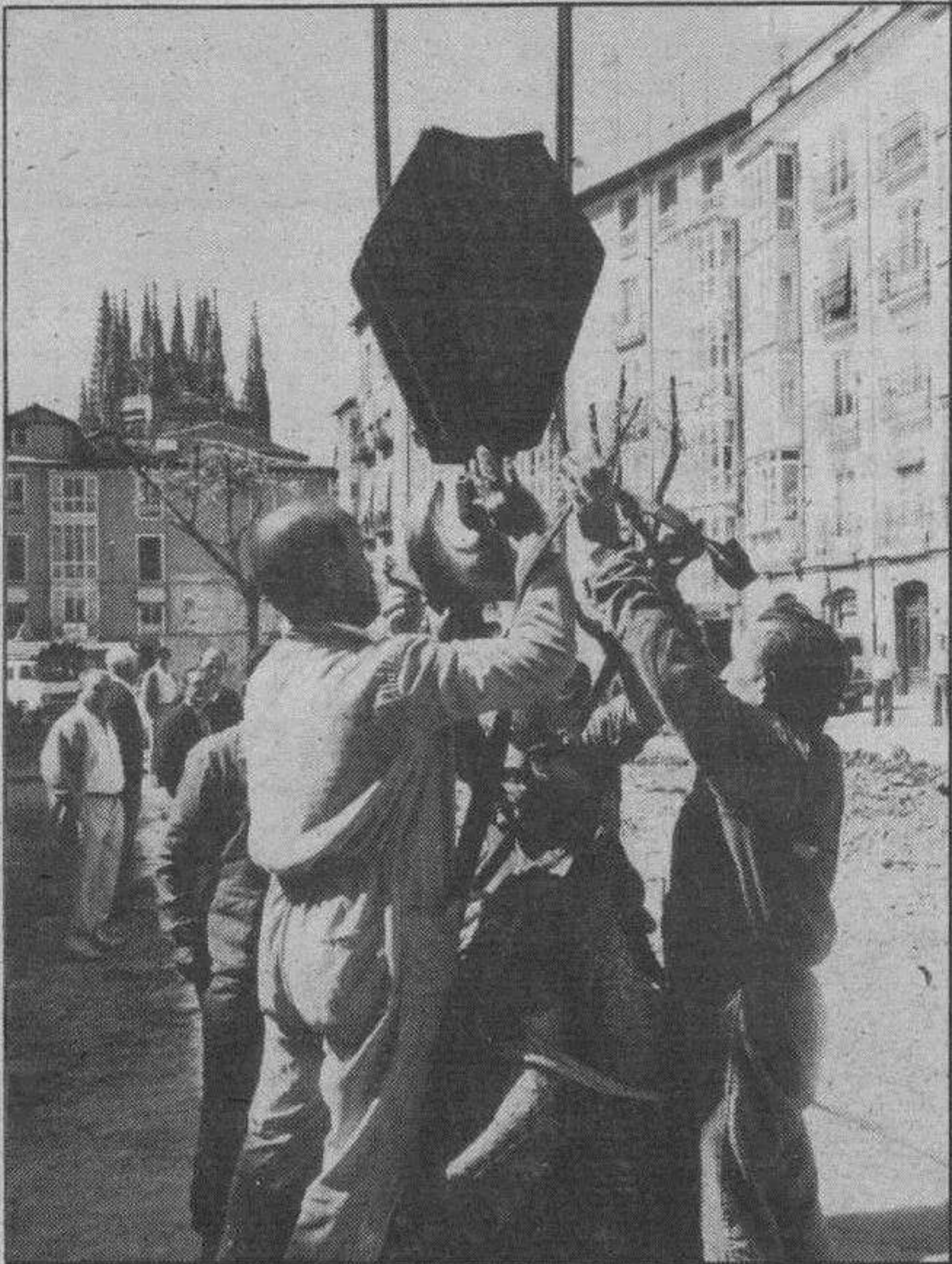
Habían sido numeradas todas las piezas antes de comenzar a desmontarlas. Foto L. López Araico
