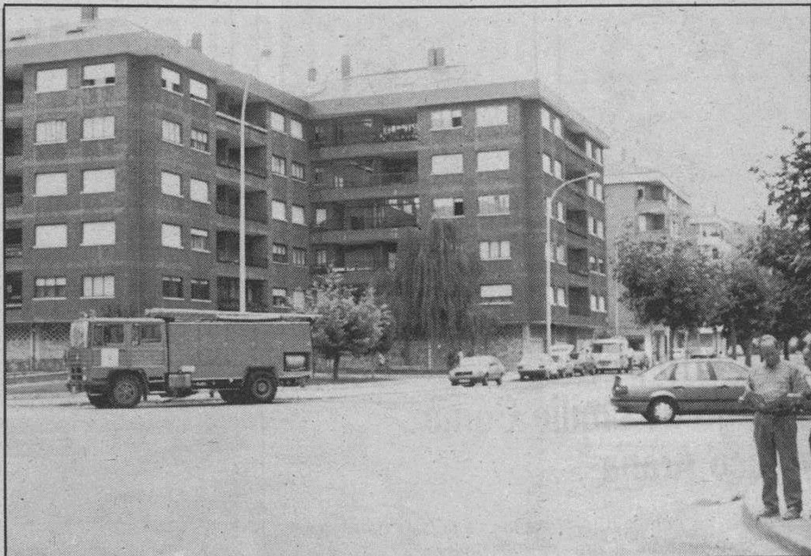
Briviesca: Nuevas edificaciones en nuestra ciudad.
