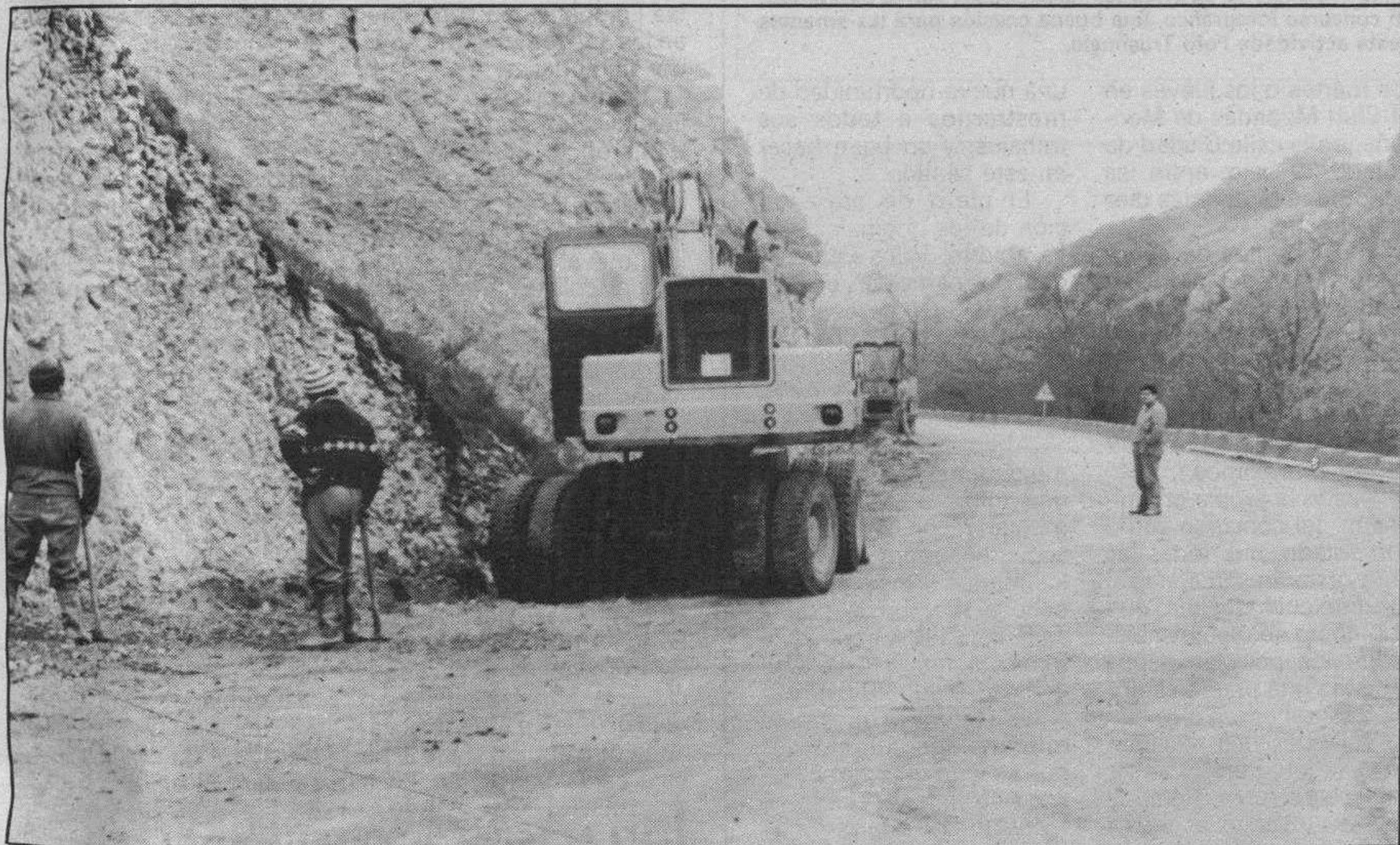
Trabajos de enterramiento de cable telefónico entre Montorio y Huérmeces.
