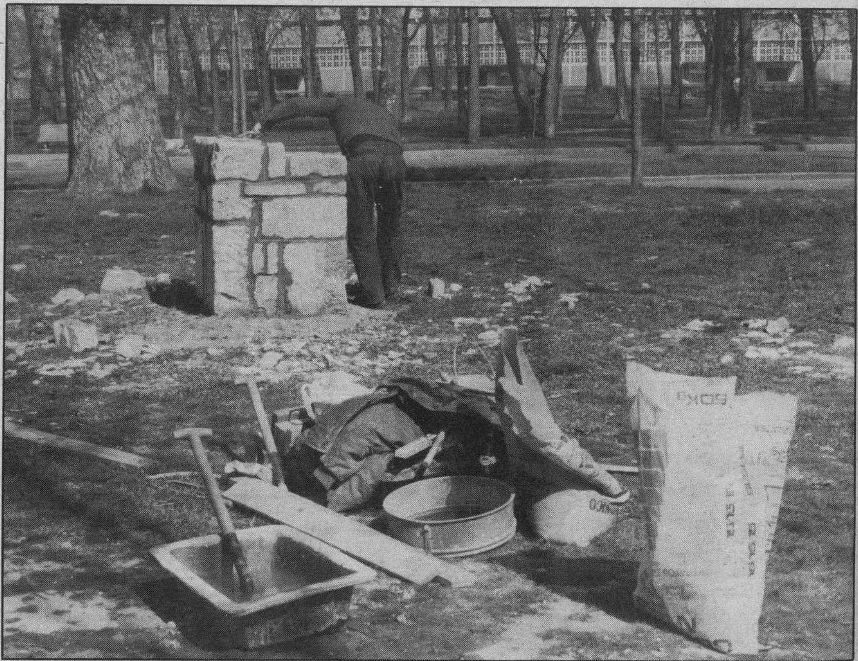
Preparando el verano. — Estos días se procede a la reparación de las cocinas en la zona de «Las Veguillas». Han sufrido deterioros por el fuego o la acción gamberril y conviene que estén dispuestas para el próximo verano. En esos quehaceres ha sorprendido nuestra cámara a este operario municipal.
