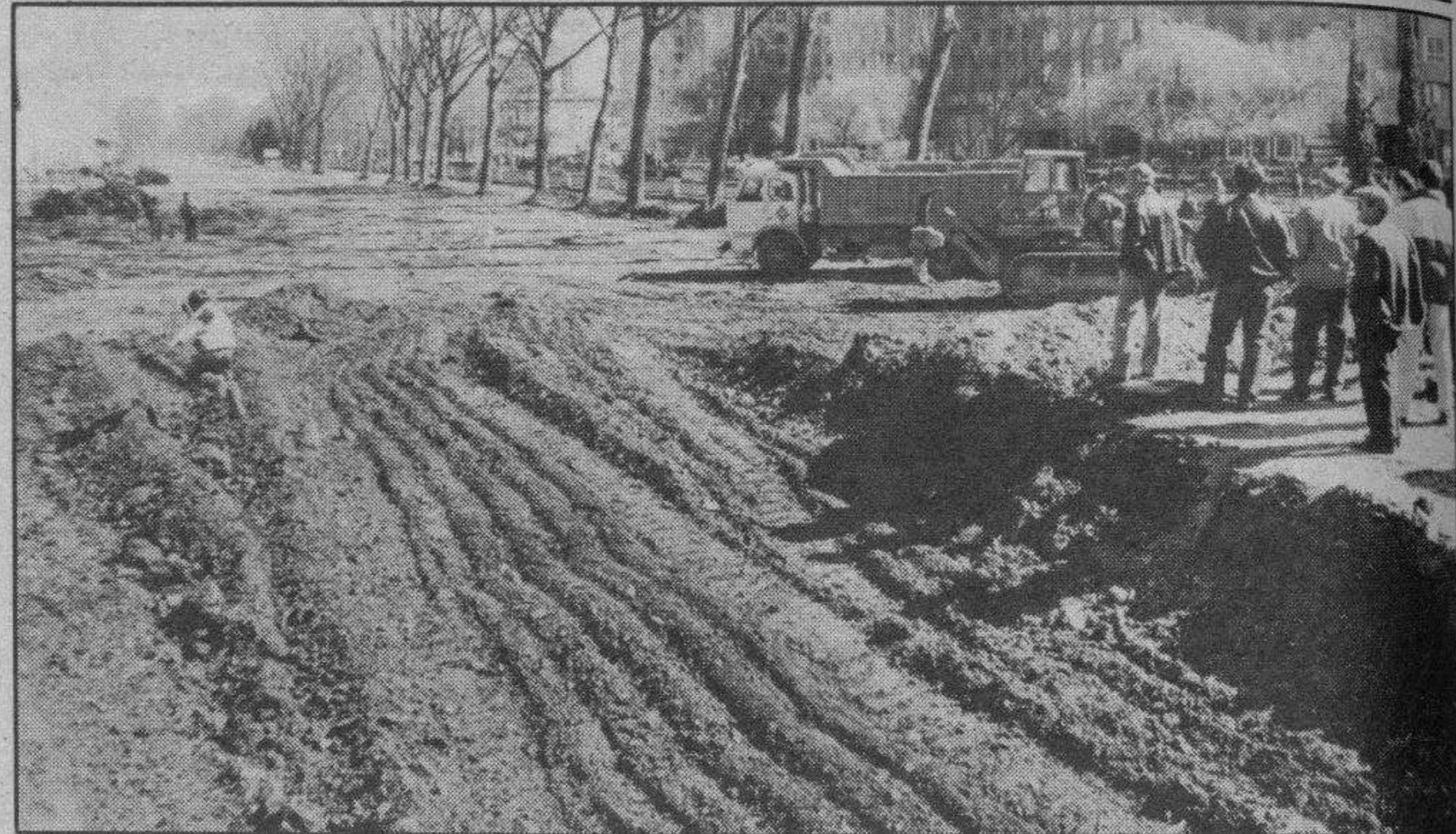
Trabajos de mejora de la Avenida de Reyes Católicos Norte. — Las fotografías corresponden a los trabajos de explanación de terrenos afectados por el proyecto de urbanización de la primera fase del Area de actuación C-9 (Reyes Católicos Norte), cuyas obras ha adjudicado el Ayuntamiento a la empresa CADOCSA, en 82 millones y medio de pesetas, y a las que seguirá, dentro de varios meses, la segunda fase en otra licitación ya en trámite, según anunció nuestro Periódico. Las obras actualmente en concurso suponen el derribo de árboles, cuyo estado aconsejaba la tala —en opinión de los técnicos municipales— y que serán compensados con una repoblación forestal más acorde con el entorno de la citada avenida. Se trata de la infraestructura de un nuevo sector vecinal colindante con el Barrio de La Sagrada Familia
