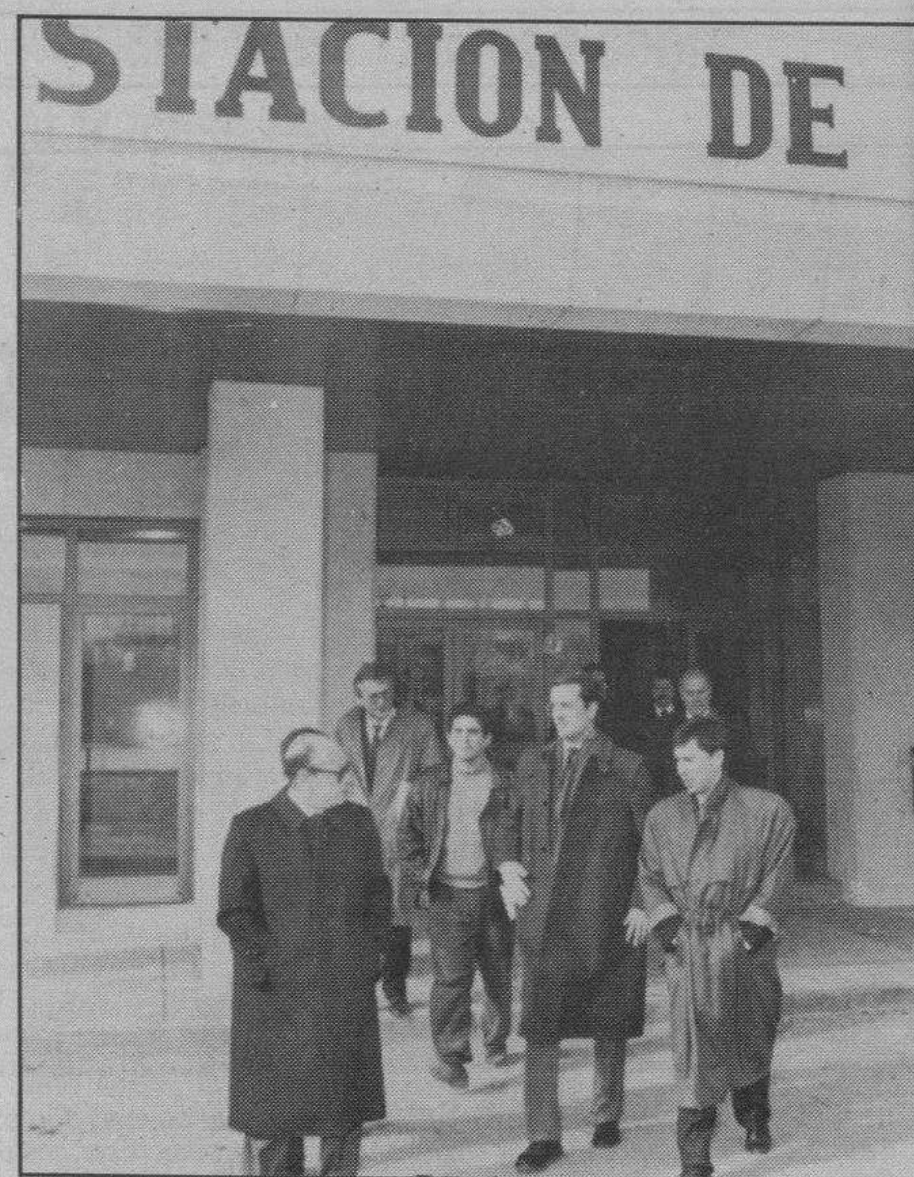
Miembros de la Junta de Castilla y León tras visitar las obras de la Estación de Autobuses. Foto Lara.
