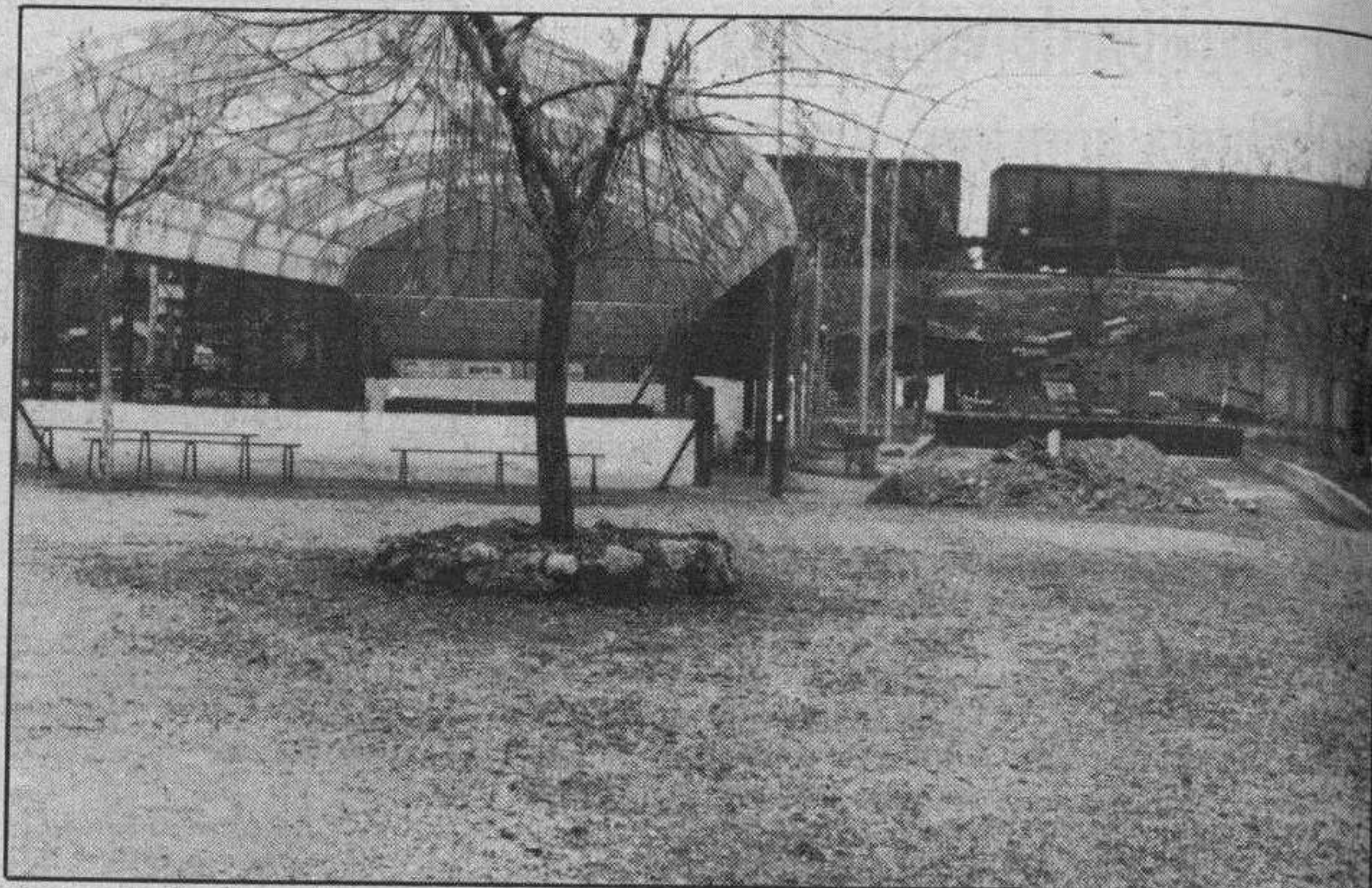
La bolera de Aquende es otra vez noticia. Ahora sus socios han comenzado la realización de las obras que concluirán con la instalación de un suelo de cuarzo. Después de haber sido cubierta, los proyectos de mejora continúan. Foto Truchuelo.
