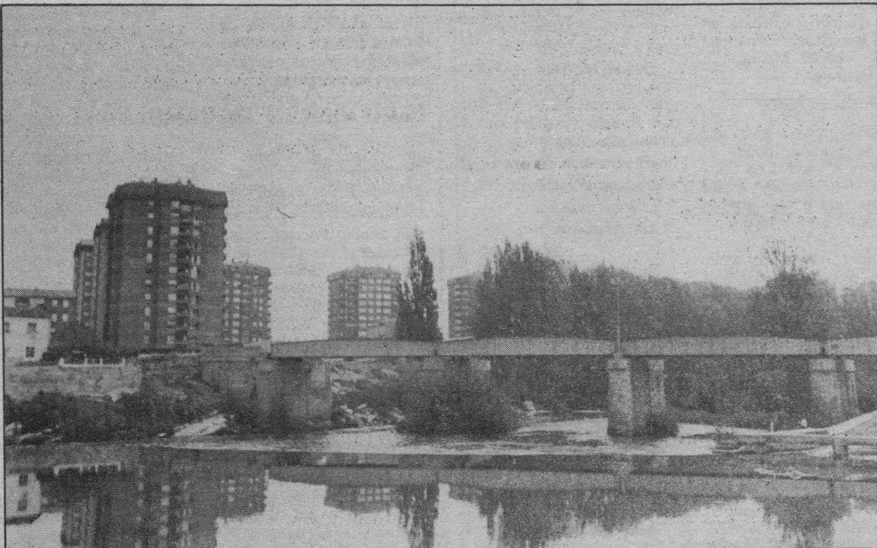
El Polígono Residencial de Anduva, algunas de cuyas torres vemos en la fotografía, quedará a tres minutos andando de la Barriada de San Juan del Monte, cuando actualmente en coche la distancia a recorrer supone casi un cuarto de hora. Son ventajas que reportará este magnífico proyecto complementario al de la Ronda del Ferrocarril. — Foto Truchuelo.
