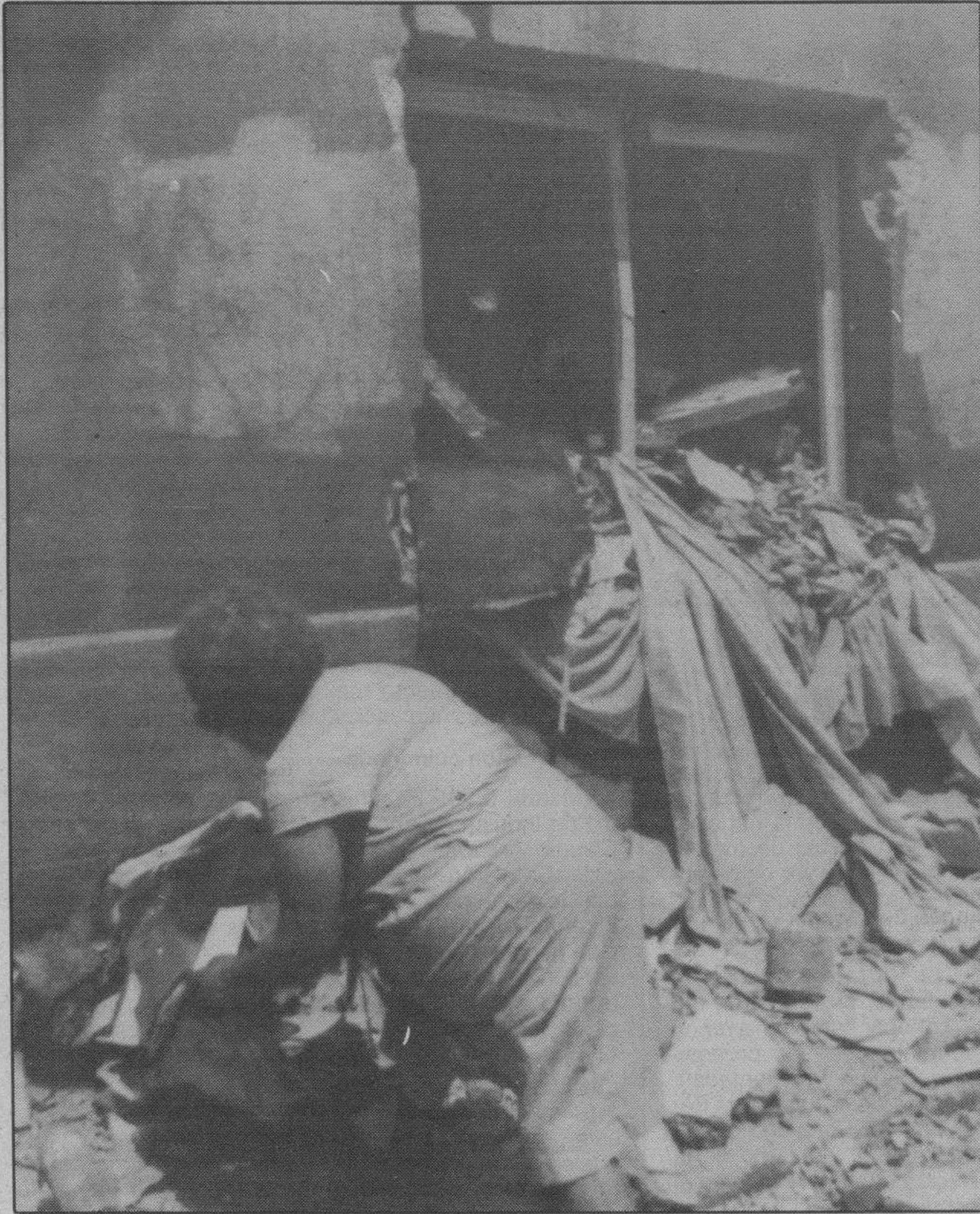
El derrumbamiento de un inmueble en Badalona causó la muerte de una persona y heridas a otras cuatro. Una de las inquilinas del inmueble siniestrado recoge los enseres de su piso entre las ruinas del edificio.-Telefoto Efe.
