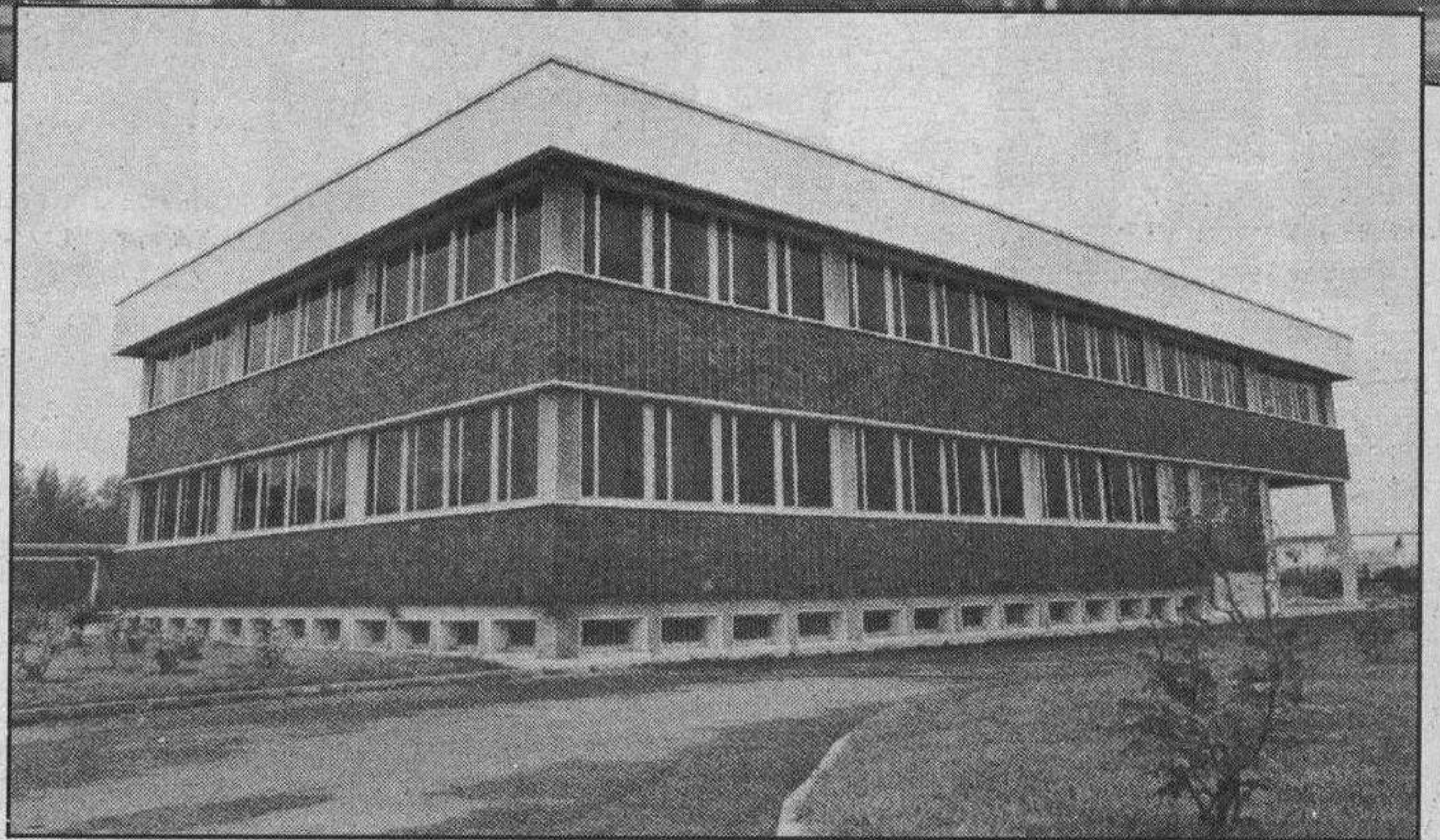
Instalaciones de Montefibre Hispania en Miranda de Ebro
