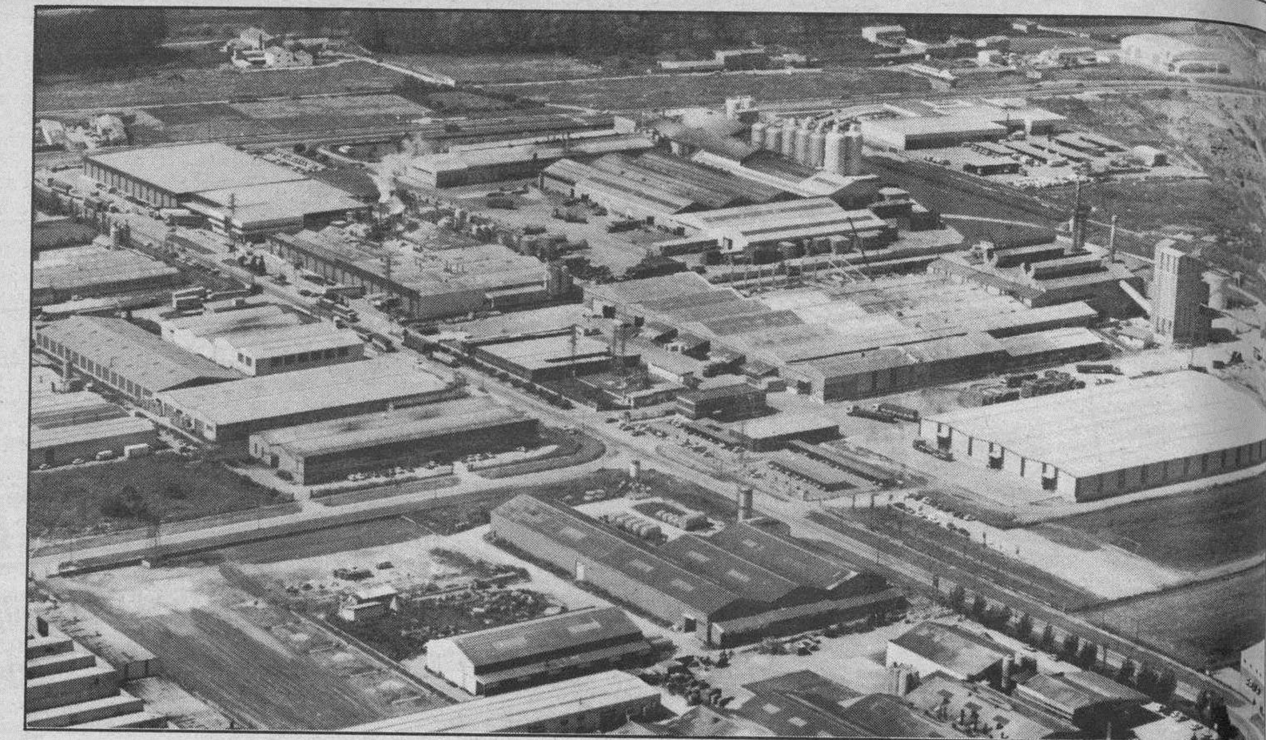
Foto aérea del Polígono Industrial de Gamonal-Villimar.
