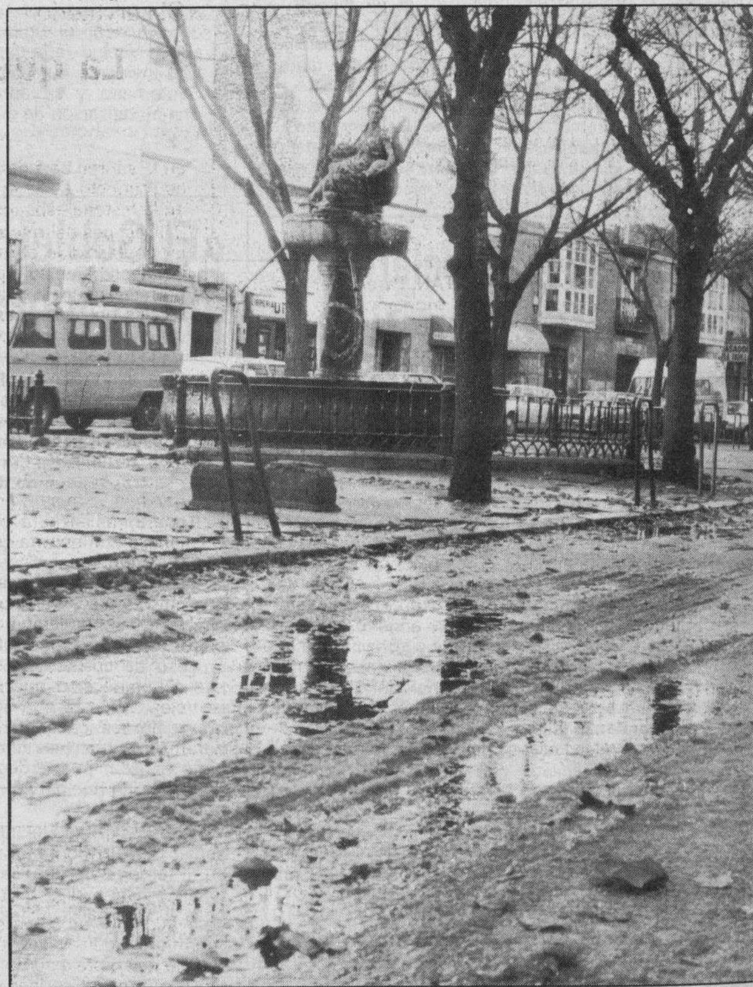
La Flora, un desastre. — Se acrecientan las quejas de los vecinos de la plaza de Huerto del Rey por el mal estado de las condiciones de la típica fuente, sus desagües y problemas que impiden un buen servicio y constituyen un escándalo de la propia calle y de la ciudad. Los desbordamientos del agua causan charcas y lagunas que agravan el deterioro del pavimento. Los vecinos exigen una solución lo más rápidamente posible.
