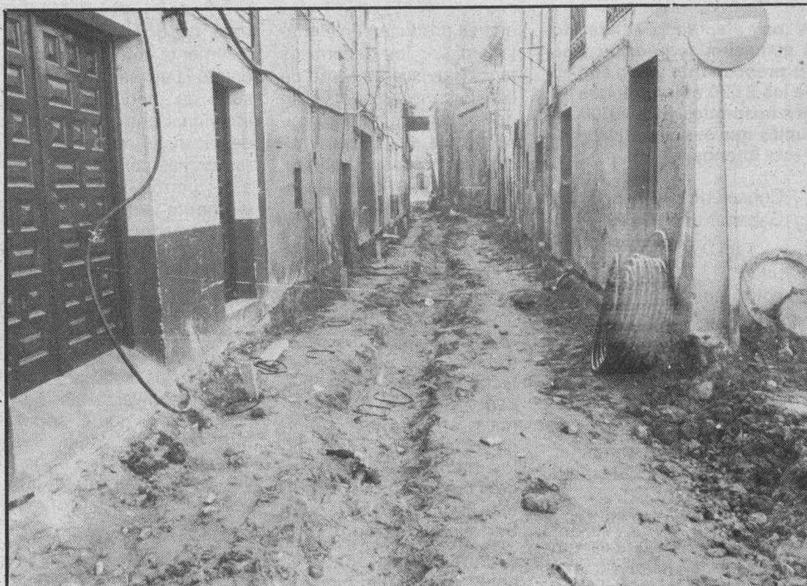
Nuevas pavimentaciones. — Así está actualmente la calle de La Cruz, del popular y vetusto barrio de Aquende, como lo están también las de las Escuelas, Hornos y otras callejas. El plan de nueva pavimentación y saneamiento del viejo barrio sigue adelante y, con un poco de suerte —si el tiempo acompaña—, para finales de año estará totalmente pavimentado el casco antiguo. La pavimentación se va a realizar con adoquines de piedra artificial, que ya están apilados en las cercanías de las calles afectadas, a la espera de que una vez terminadas las obras de saneamiento y firme, sean colocados. Después, cuando las obras queden terminadas, se pondrá en servicio un nuevo sistema de semáforos, que regularán la circulación rodada por el barrio, semáforos que ya están siendo instalados y, definitivamente, todo el sector urbano citado, pasará a ser peatonal (Foto Truchuelo).
