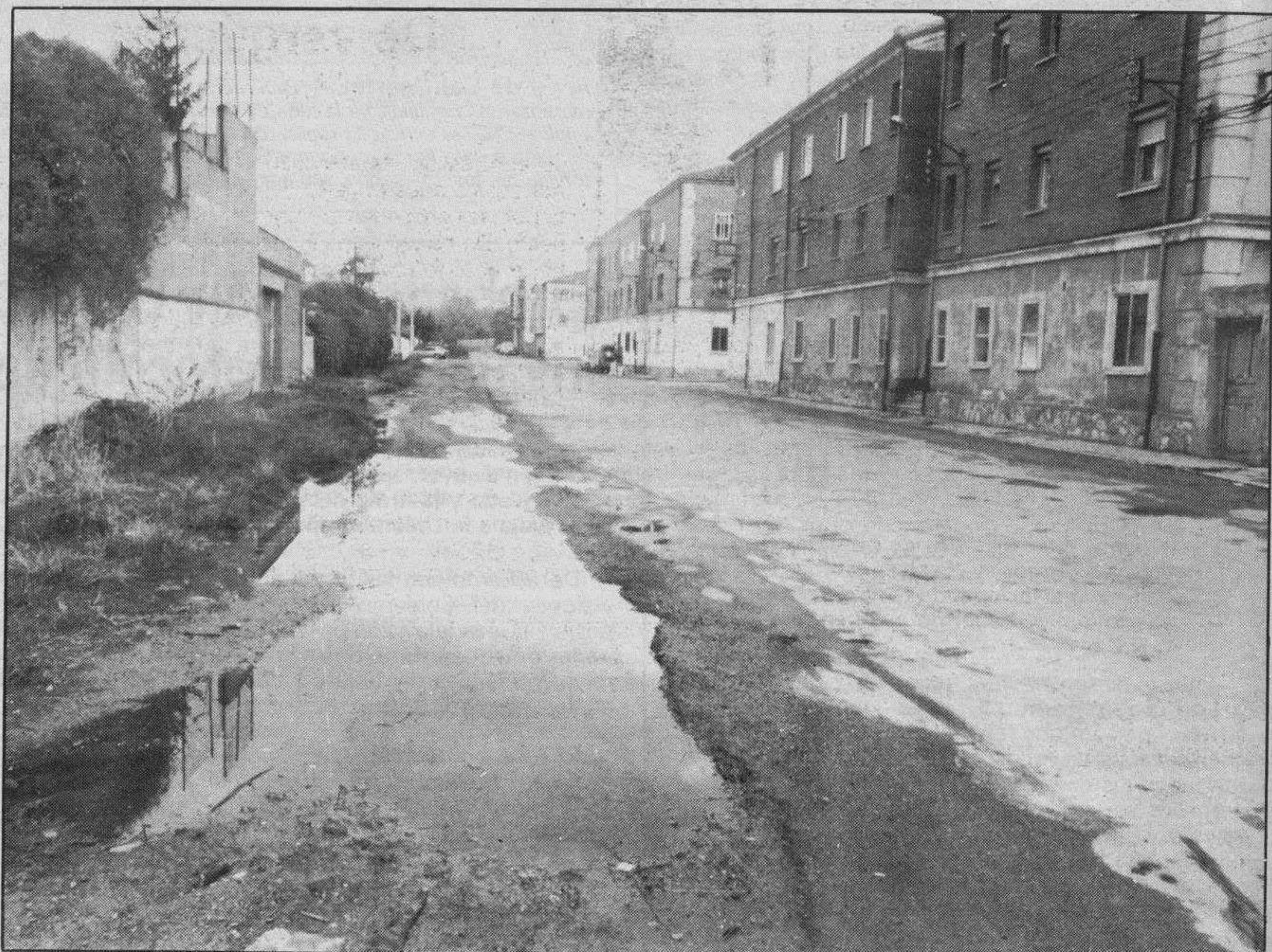
Nueva queja. — Otra vez los vecinos de la prolongación de la calle de San Pedro de Cardena, en el tramo que va desde el puente de la Ronda hasta el final se quejan del estado de su calle. Los charcos y la falta de dotaciones ha sido motivo de una carta dirigida al Ayuntamiento y solicitaban una fotografía del lugar. Ahí la tienen. El Concejo no tardará en reaccionar. Eso esperan.
