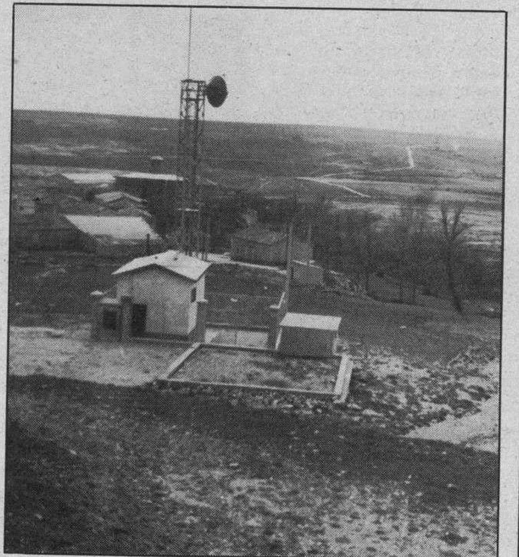
Vista exterior de la central radiotelefónica.
