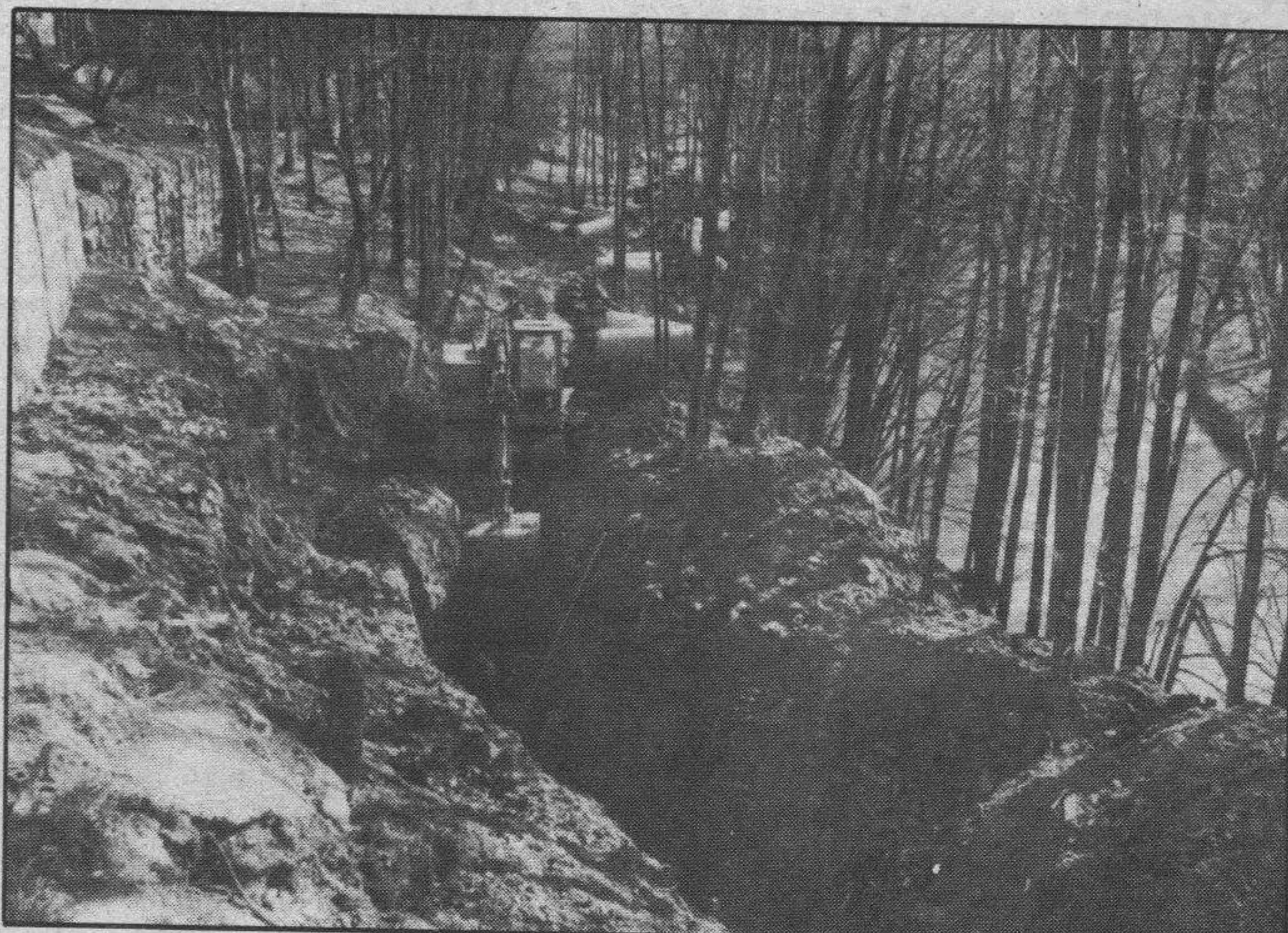
Obras del colector, margen derecha del Duero en Aranda. — Foto Lara.
