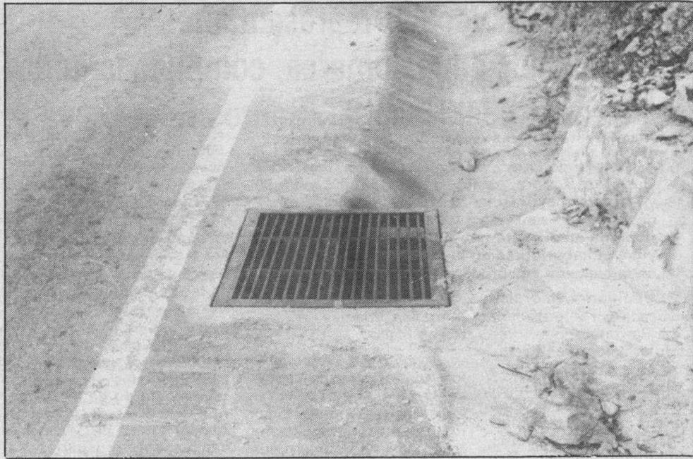
Detalle de la rejilla mal colocada en la salida de Escalada
