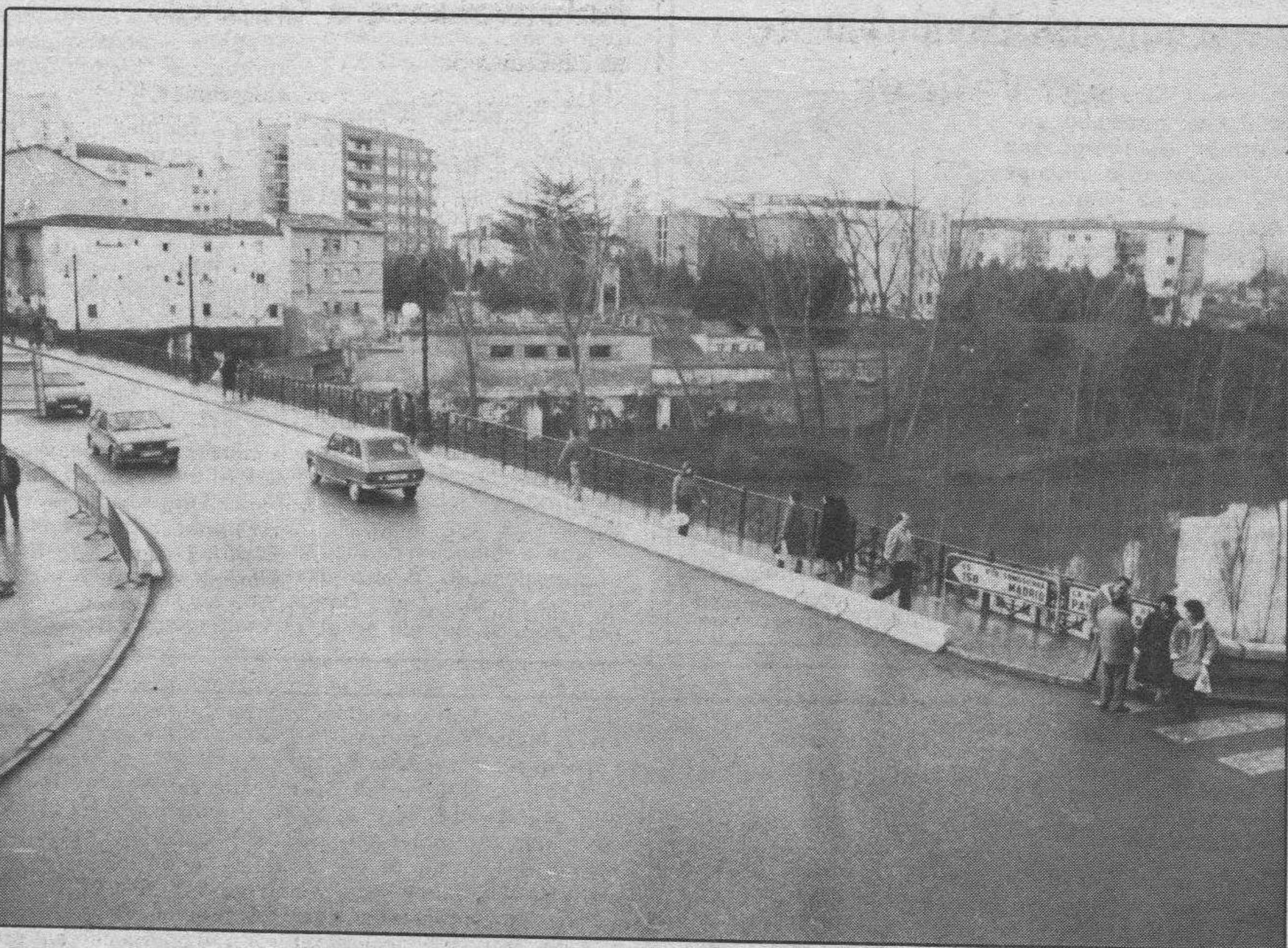
Sobre el Duero. — Desde Aranda nos llega esta Retina de Florentino Lara. Por fin se ha colocado la protección en el puente para que los peatones no corran ningún riesgo. Es un detalle municipal y así lo destacamos.
