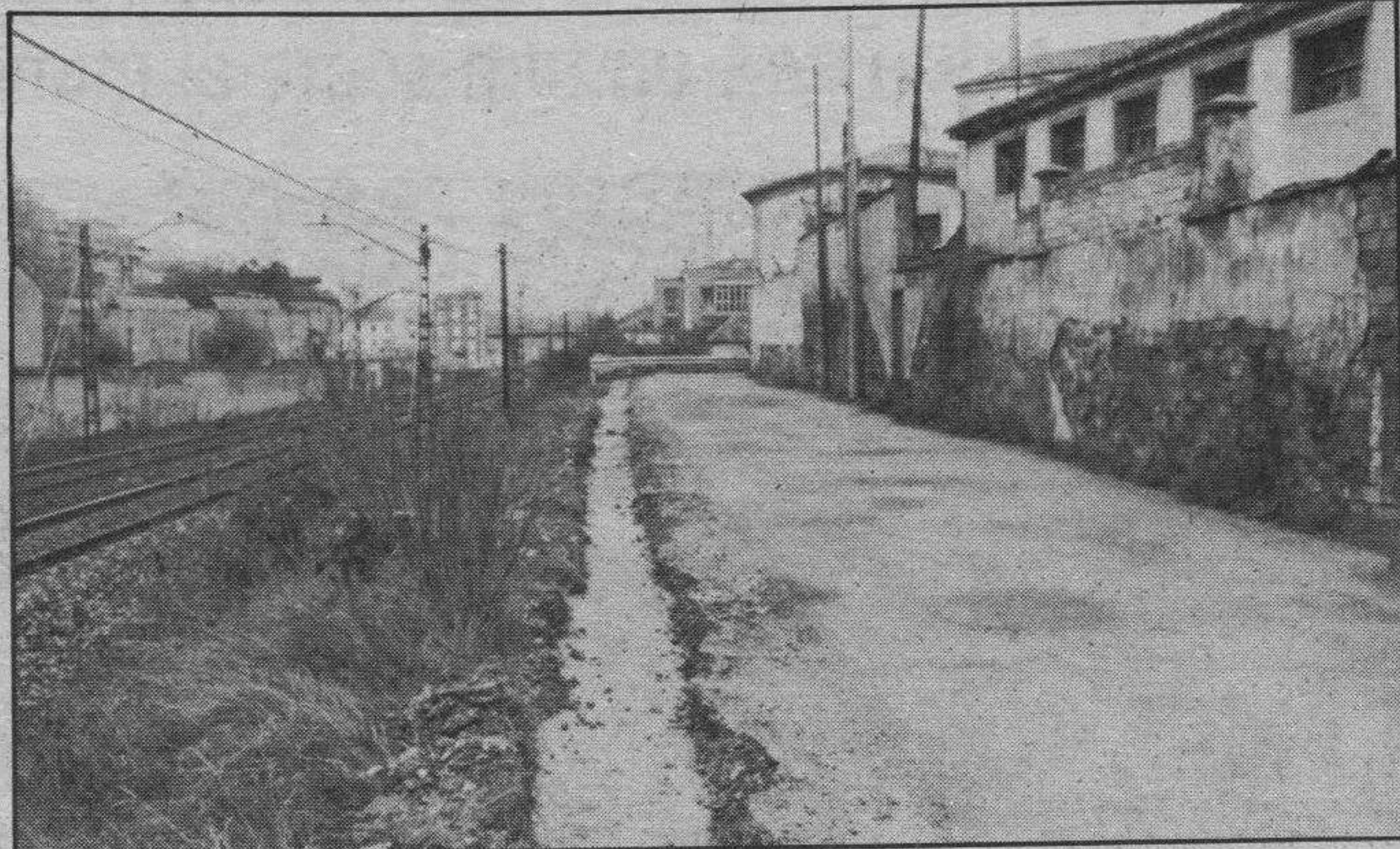
Calle Rivalamora donde se aprecia la cimentación para la tapia.
