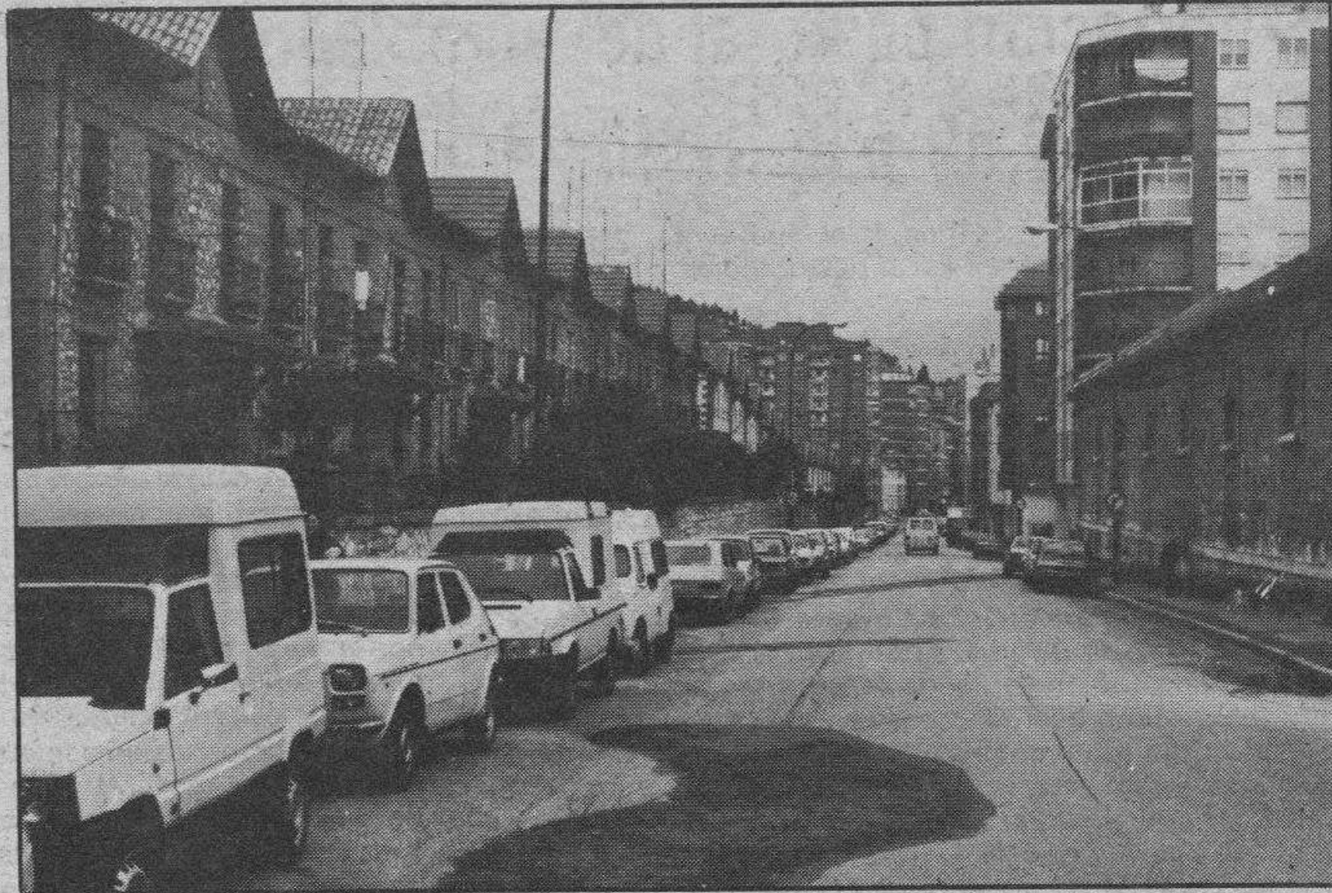
La Comisión Municipal de Gobierno aprobó proyectos de renovación de la red de distribución de agua y de alcantarillado en varias calles, una de ellas es la de San Francisco.
