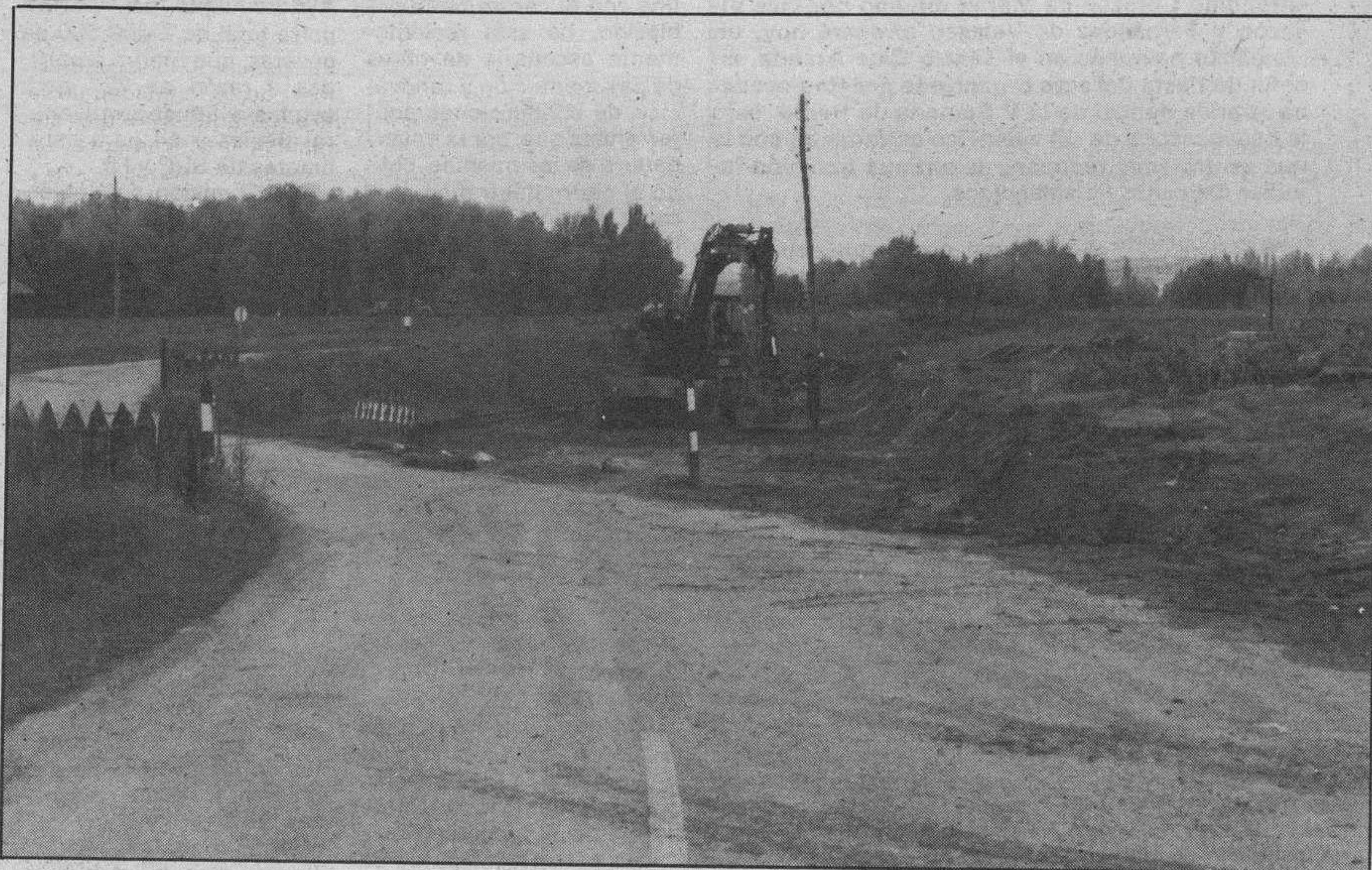
Detalle de las obras.
