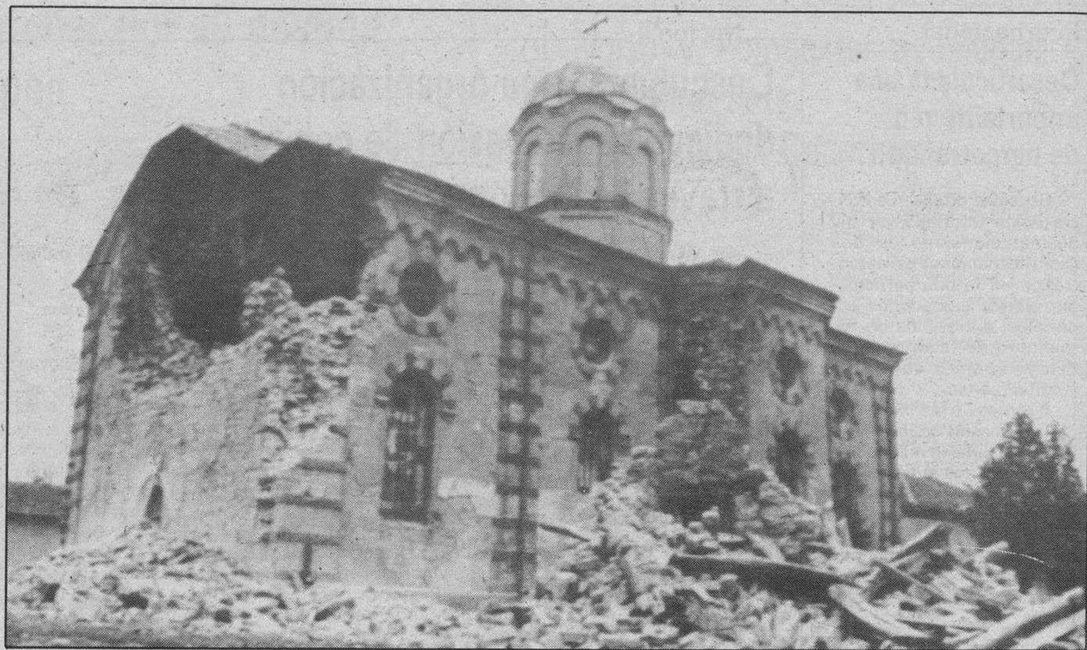
Terremoto en Bulgaria. — Una iglesia en la ciudad de Strazhitsa (Bulgaria) resultó dañada por un terremoto que alcanzó el grado 5,5 en la escala de Richter. A causa del seísmo murieron tres personas y otras treinta resultaron heridas. Telefoto Reuter-Efe
