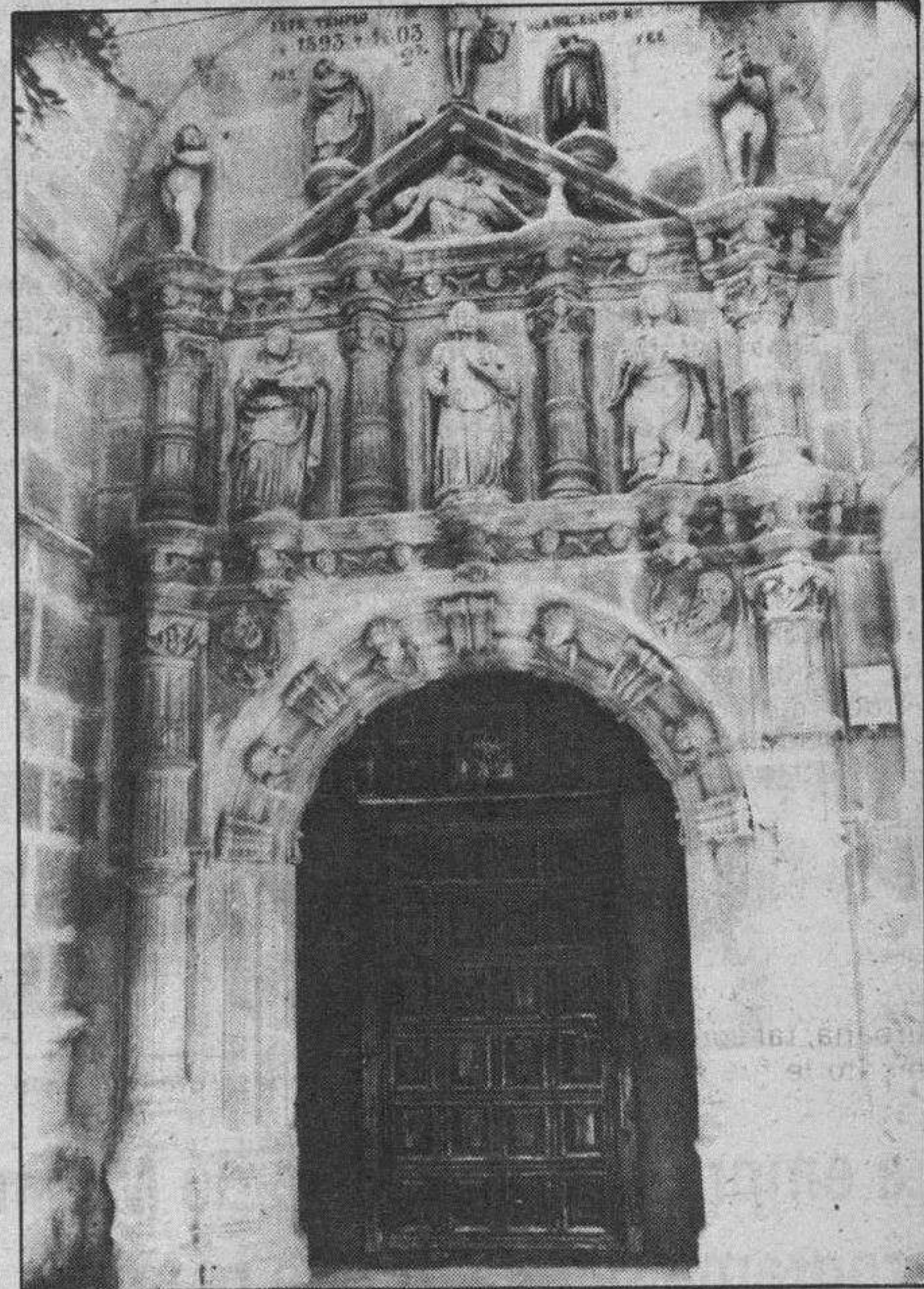
Hermosa portada de la iglesia de Zael, cuyas obras de restauración se inauguraron el lunes. Foto M. Angel.
