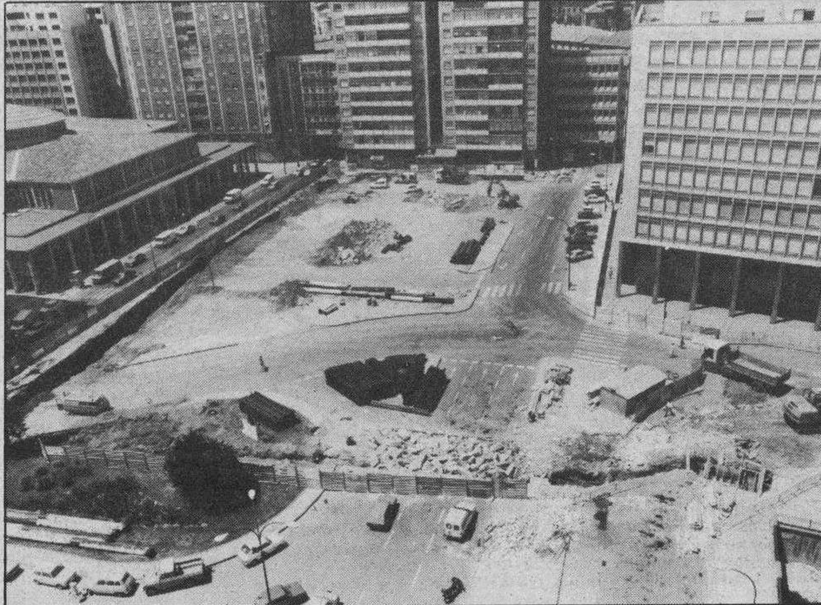
Tras varios meses de obras, el aparcamiento de la plaza de España abre hoy sus puertas.
