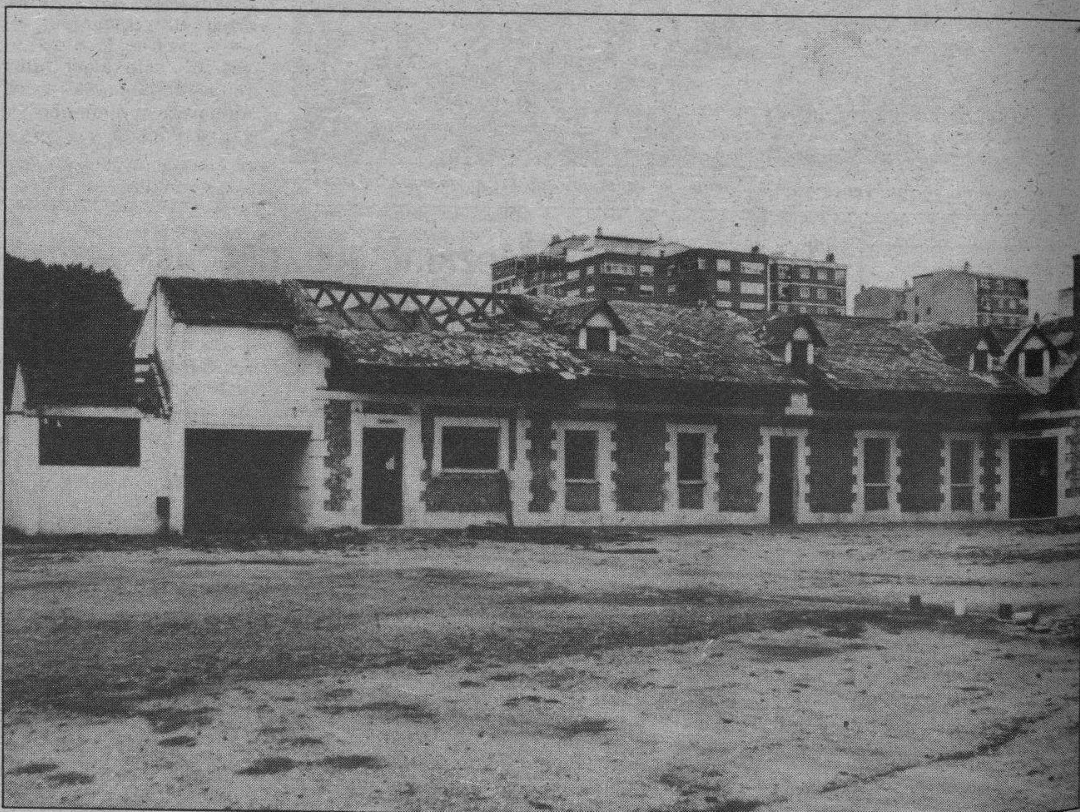
Comenzó el derribo del edificio de Veterinaria Militar. — Cumpliéndose los acuerdos convenidos entre el Ministerio de Defensa y el Ayuntamiento de Burgos, se ha iniciado el derribo del edificio de Veterinaria Militar que se alzaba en la carretera de Valladolid. Los terrenos pasarán a la ciudad para que ésta amplíe el complejo deportivo-recreativo que tiene en la zona. Una noticia de interés para los burgaleses.
