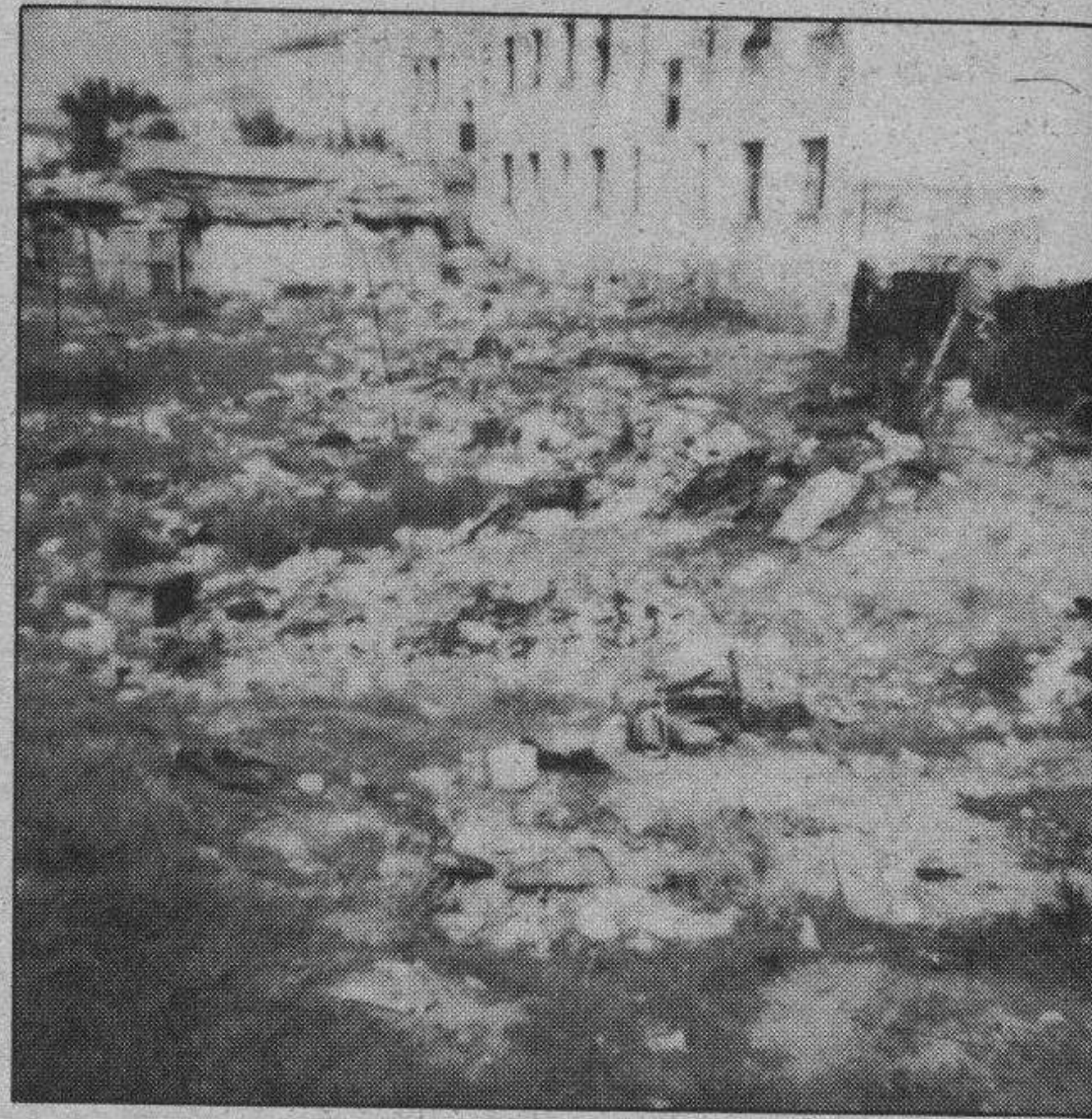
Así estaban los alrededores de ese edificio donde se hacían unos cien portugueses.
