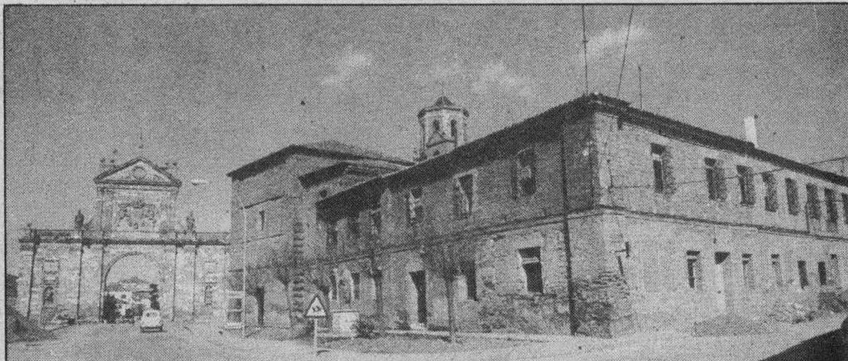
El edificio modesto de las Benedictinas de Sahagún, junto al arco del desaparecido monasterio.
