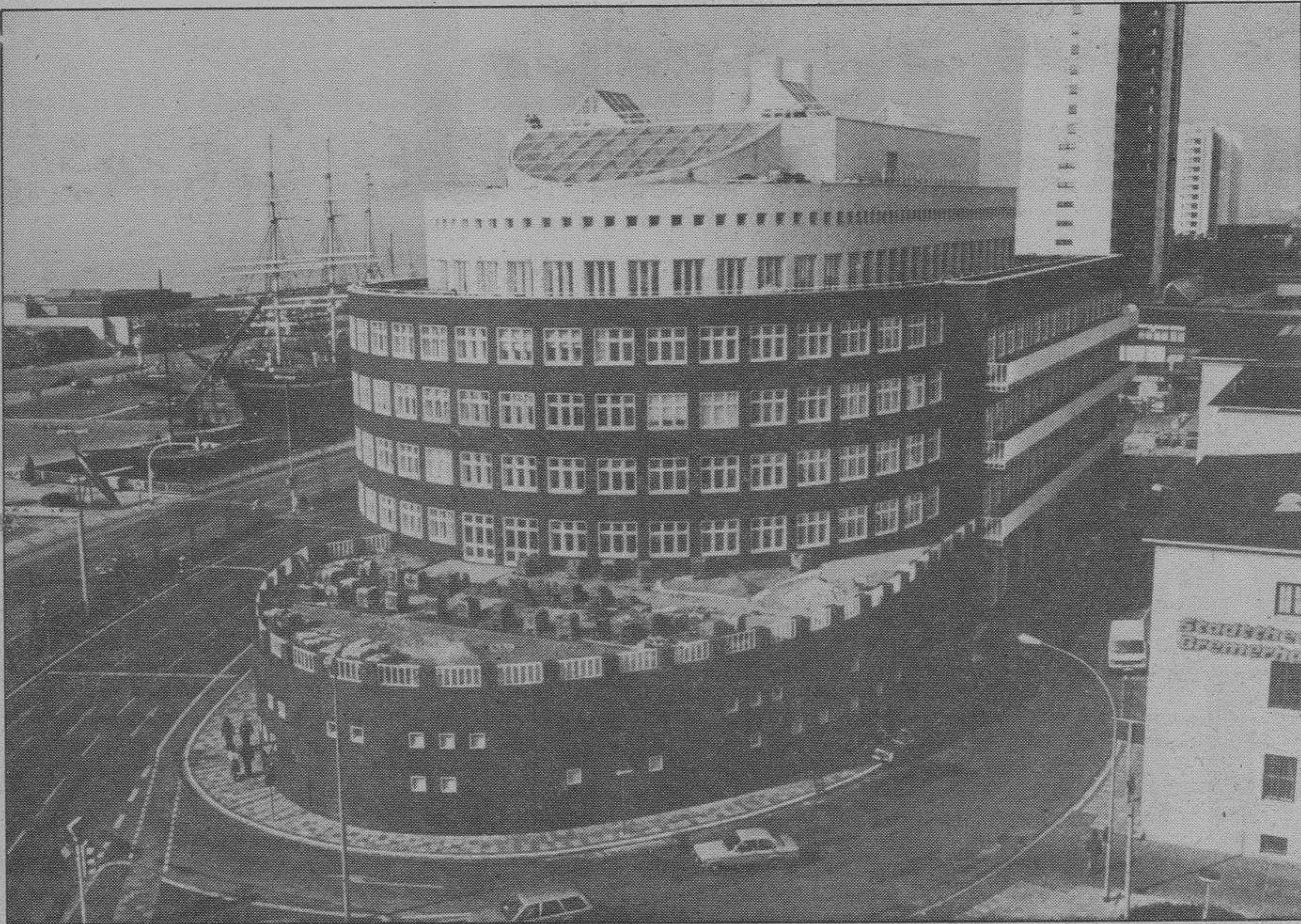
La «casa del barco». — La nueva sede del Instituto de investigaciones Oceanográficas y Polares Alfred Wegener, en el centro de Bremerhaven (República Federal de Alemania), semeja un vapor. Destacan en el complejo arquitectónico la «proa» el «puente de mando» y las tres chimeneas. La inauguración oficial tendrá lugar en Junio.
