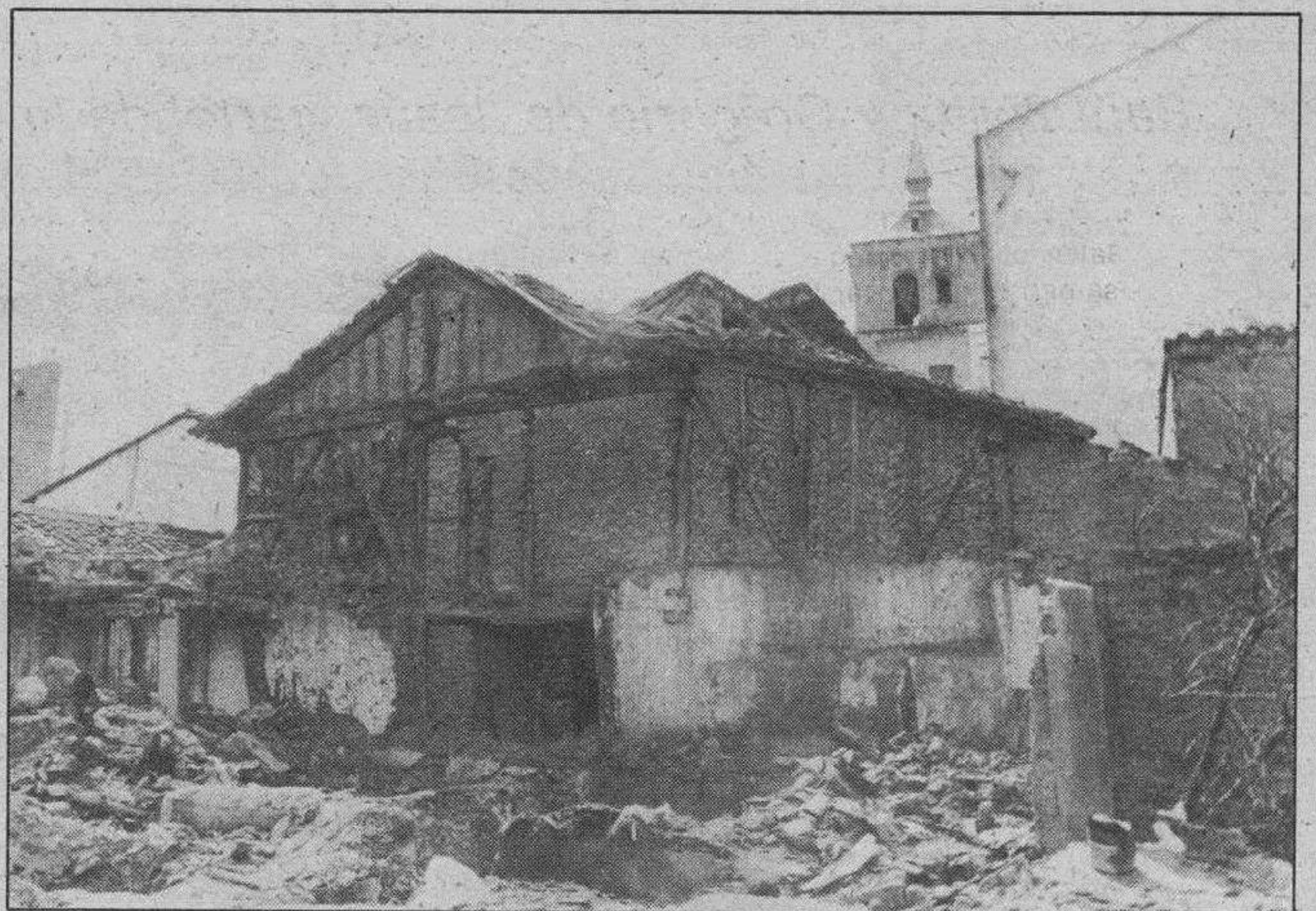
Y ésta es otra imagen del Aranda de Ayer, que reclama renovación. (Foto Lara).
