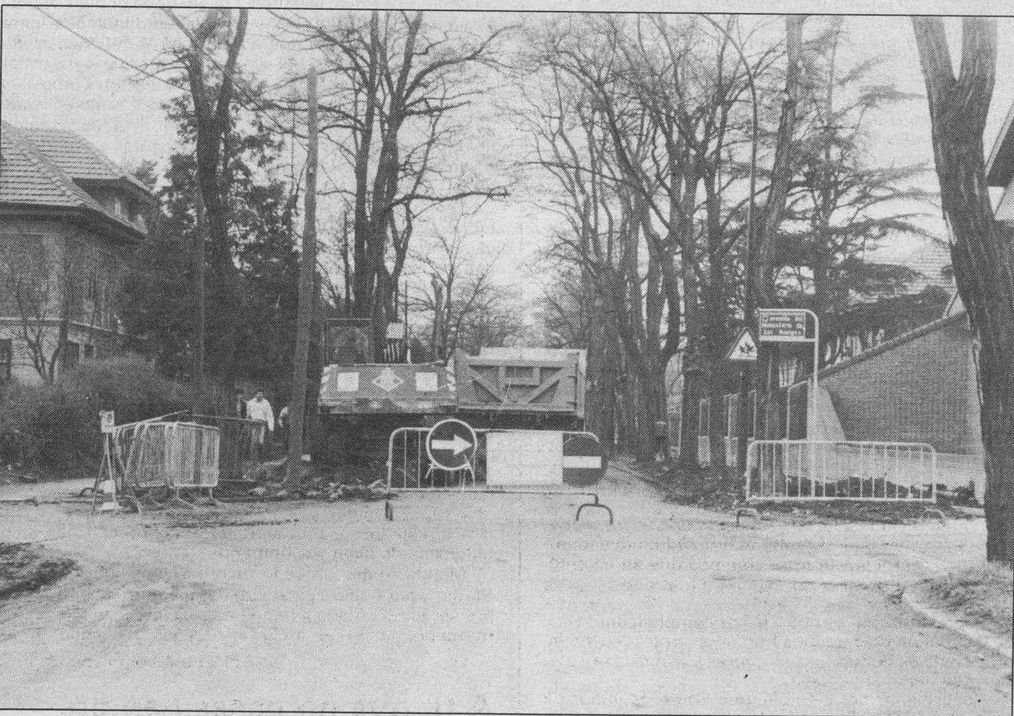
Obras hidráulicas. — En el paseo de La Castellana se están llevando a cabo obras de reposición de las tuberías de fecales y de tendido de conducciones de agua por parte de los servicios municipales correspondientes. Esto ha motivado una desviación del tráfico rodado en los accesos hacia el barrio de Las Huelgas. A eso obedece este corte de la calzada.
