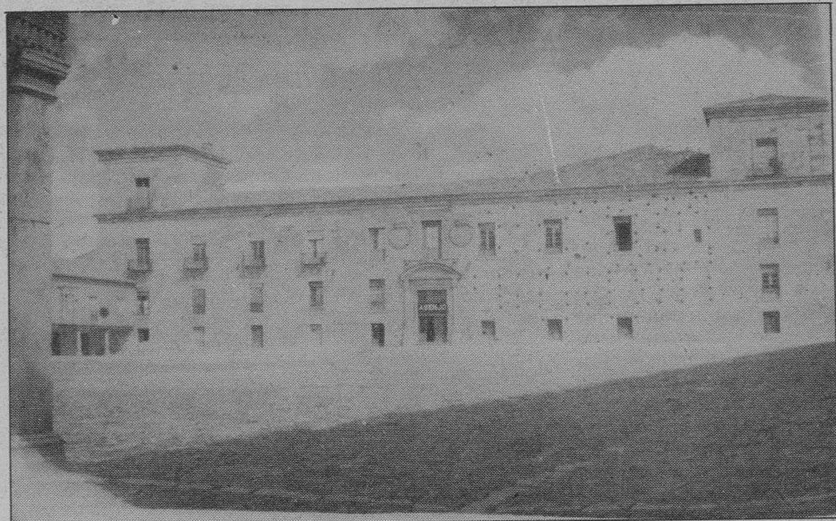
Vista actual del palacio Ducal de Lerma, donde han comenzado las obras de reparación de la cubierta.
