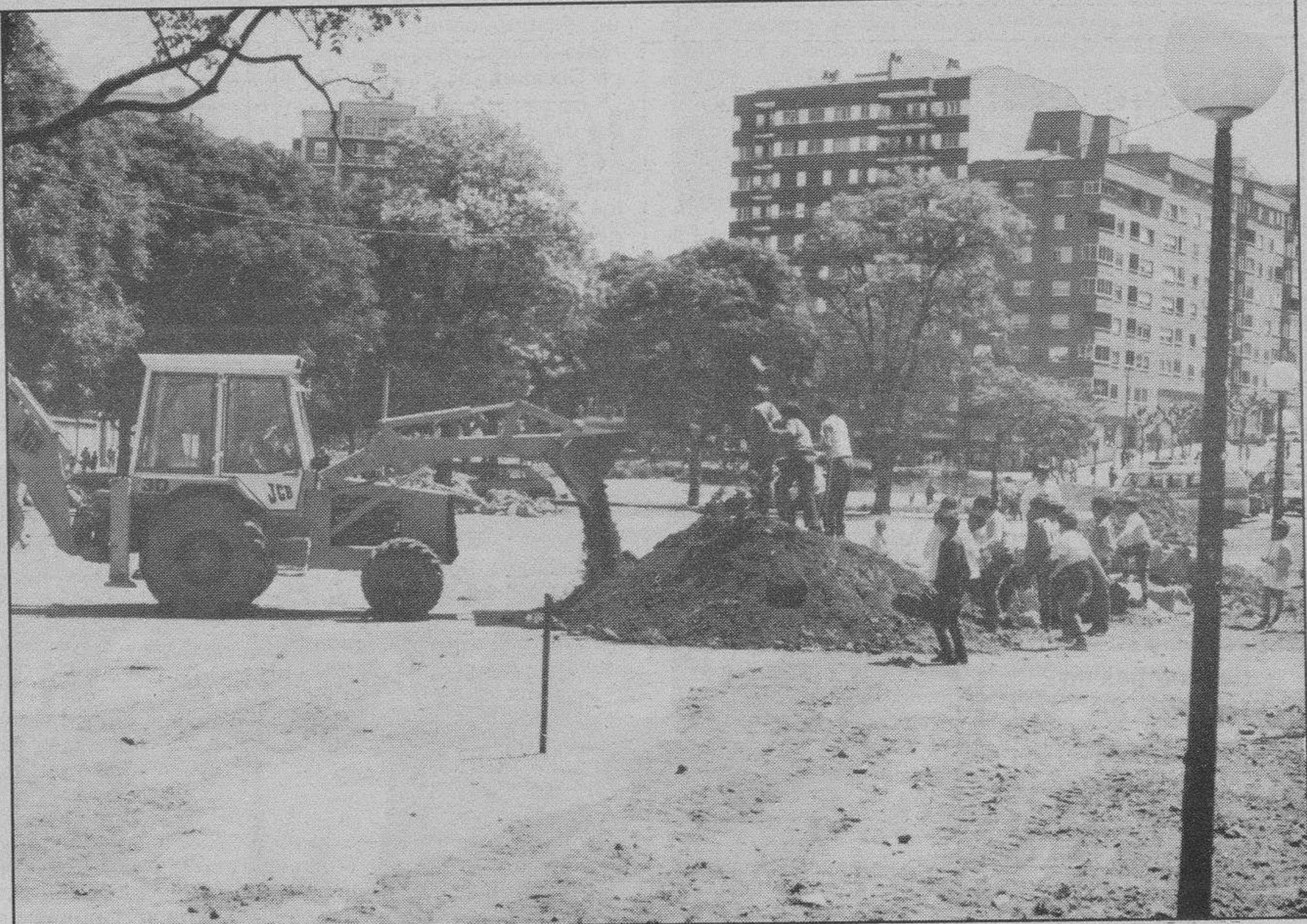
Acondicionando un parque. — Estos días se ejecutan obras en el parque de San Agustín. Se han eliminado todos los cercados de alambre, que estaban ya muy deteriorados y que constituían un peligro para los niños burgaleses que frecuentan esta zona de recreo. Alguna mejora más convendrá llevar a cabo en este momento.
