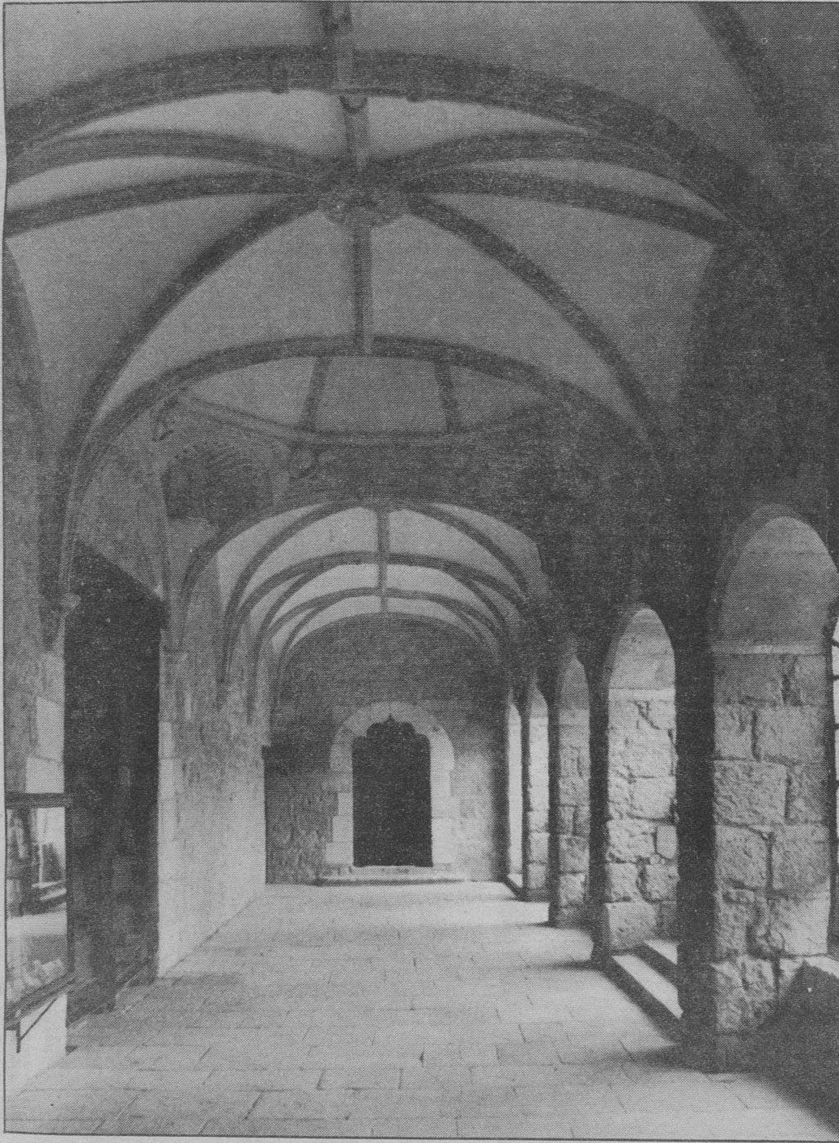
RESTAURACIONES EN LA CARTUJA. — Se han llevado a cabo últimamente interesantes restauraciones en la Cartuja de Miraflores. Una muestra de ellas es el claustro, que recoge la fotografía de V. Soto.
