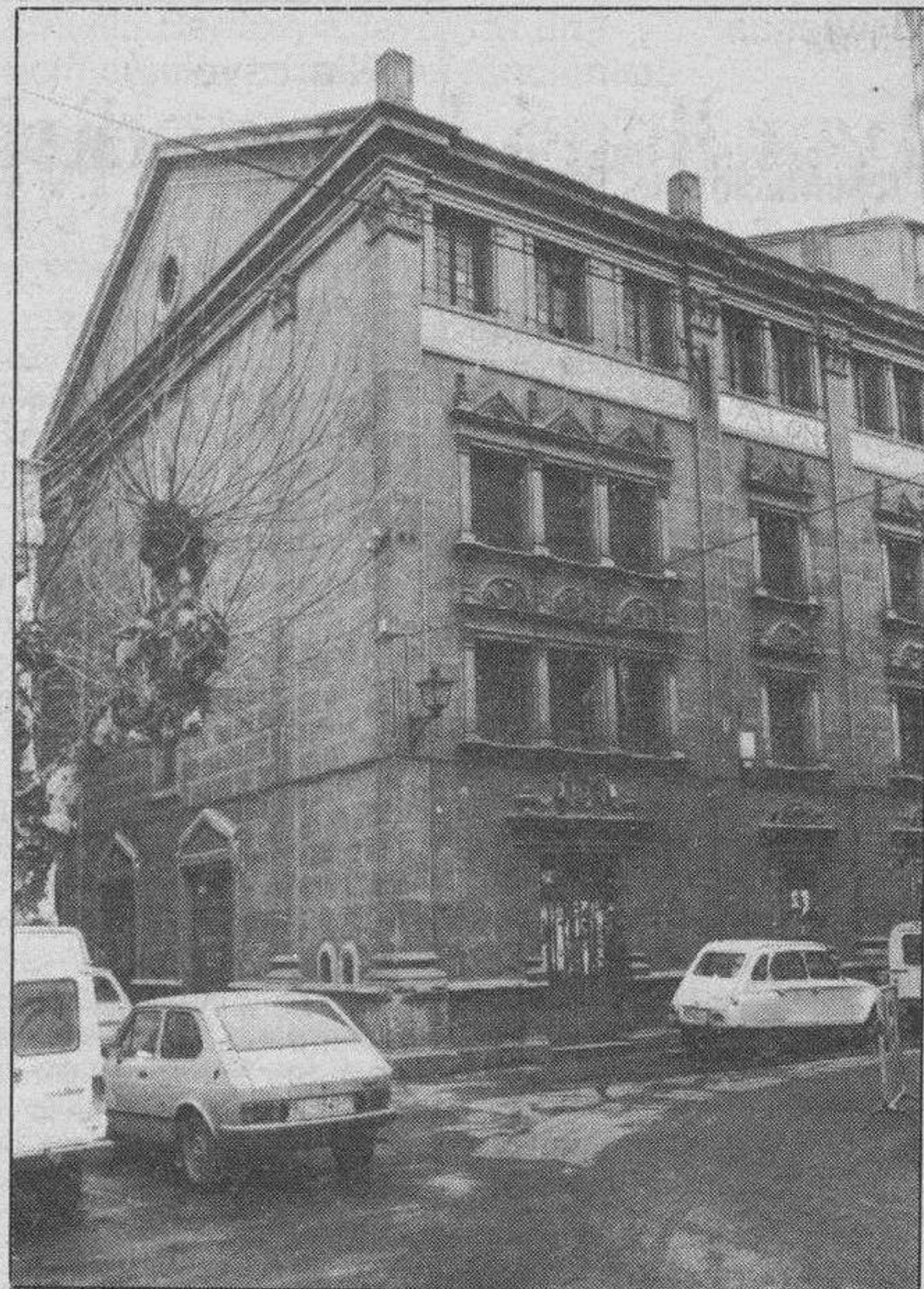
TEATRO SALÓN APOLO. — Hermoso edificio este del Teatro Salón Apolo, situado en la Plaza de Santa María, esquina a la calle de la Cruz y junto al templo parroquial de Santa María. No es viejo, vamos que tiene sesenta años escasos, ya que fue construido en 1927, por el que fuera magnífico contratista de obras, gran mirandés y entusiasta sanjuanero Sixto Erquiada Martínez, que precisamente había nacido a veinte metros de este lugar. El Teatro vino a ocupar el solar que dejara otro edificio célebre en Miranda, una especie de casino, conocido por «La Mirandesa» y que resultó destruido por un voraz incendio.
