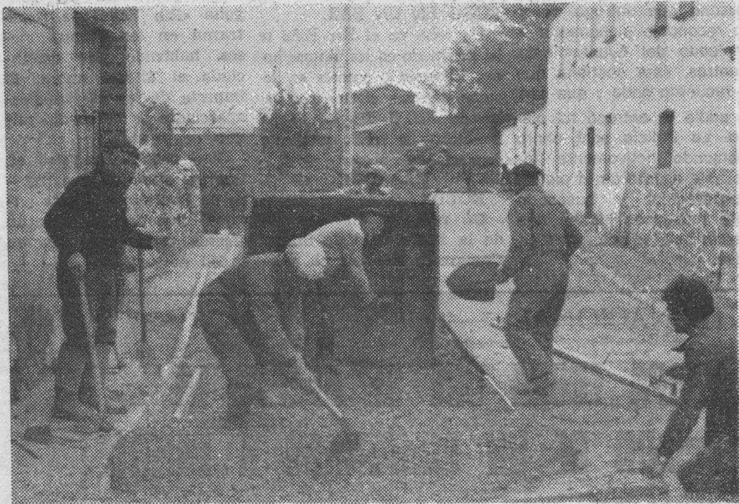
Vecinos del pueblo realizando obras de pavimentación.
