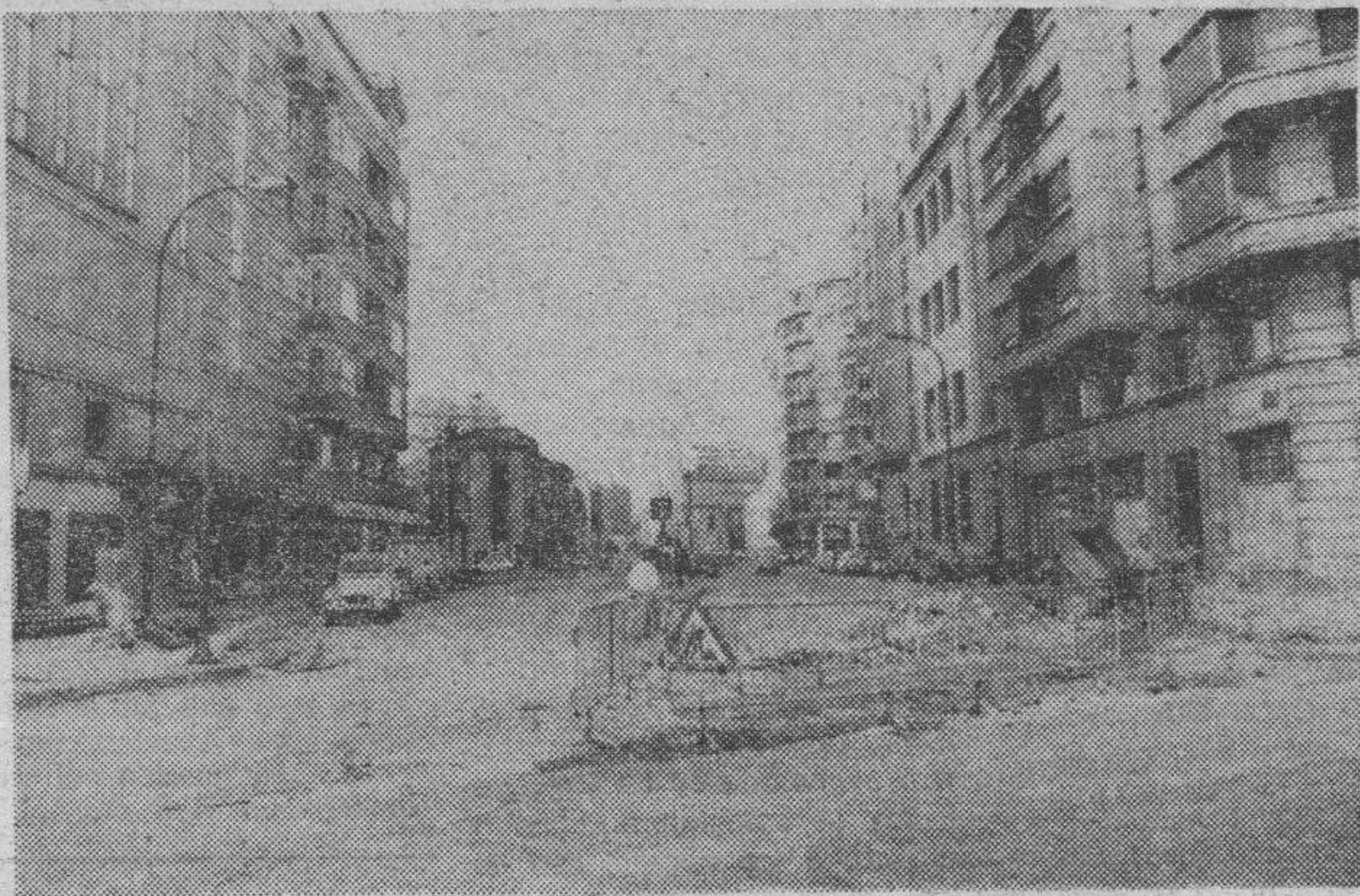
Prosiguen las obras de mejora de varias calles de la ciudad con asfalto fundido. En la fotografía la calle Conde Jordana que está sujeta a mejora general de calzadas y aceras. (Foto FEDE)
