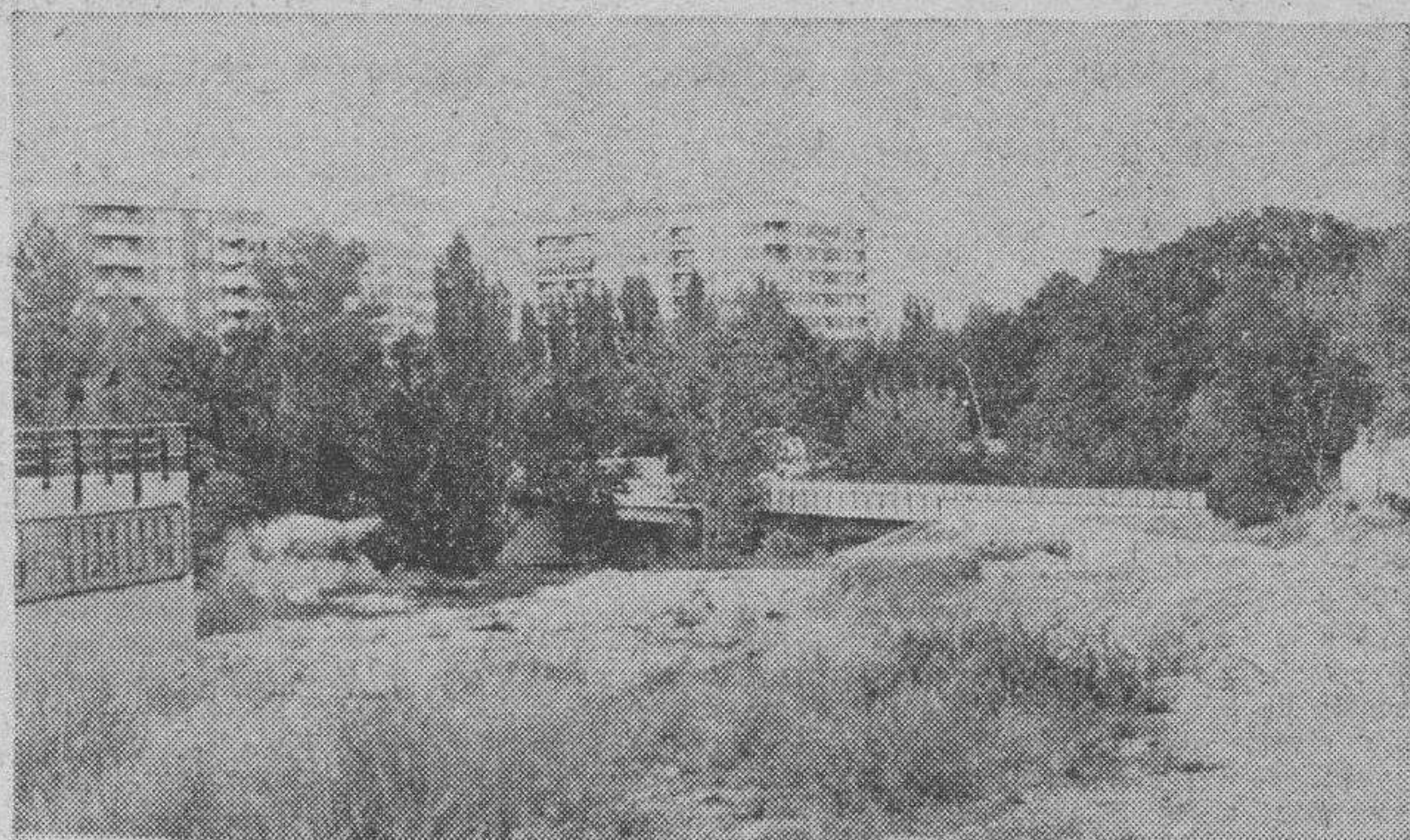
El puente de Bigar en su vertiente de la Urbanización Resinera. Un proyecto inconcluso y una necesidad a la espera de solución. — (Foto Florentino Lara).
