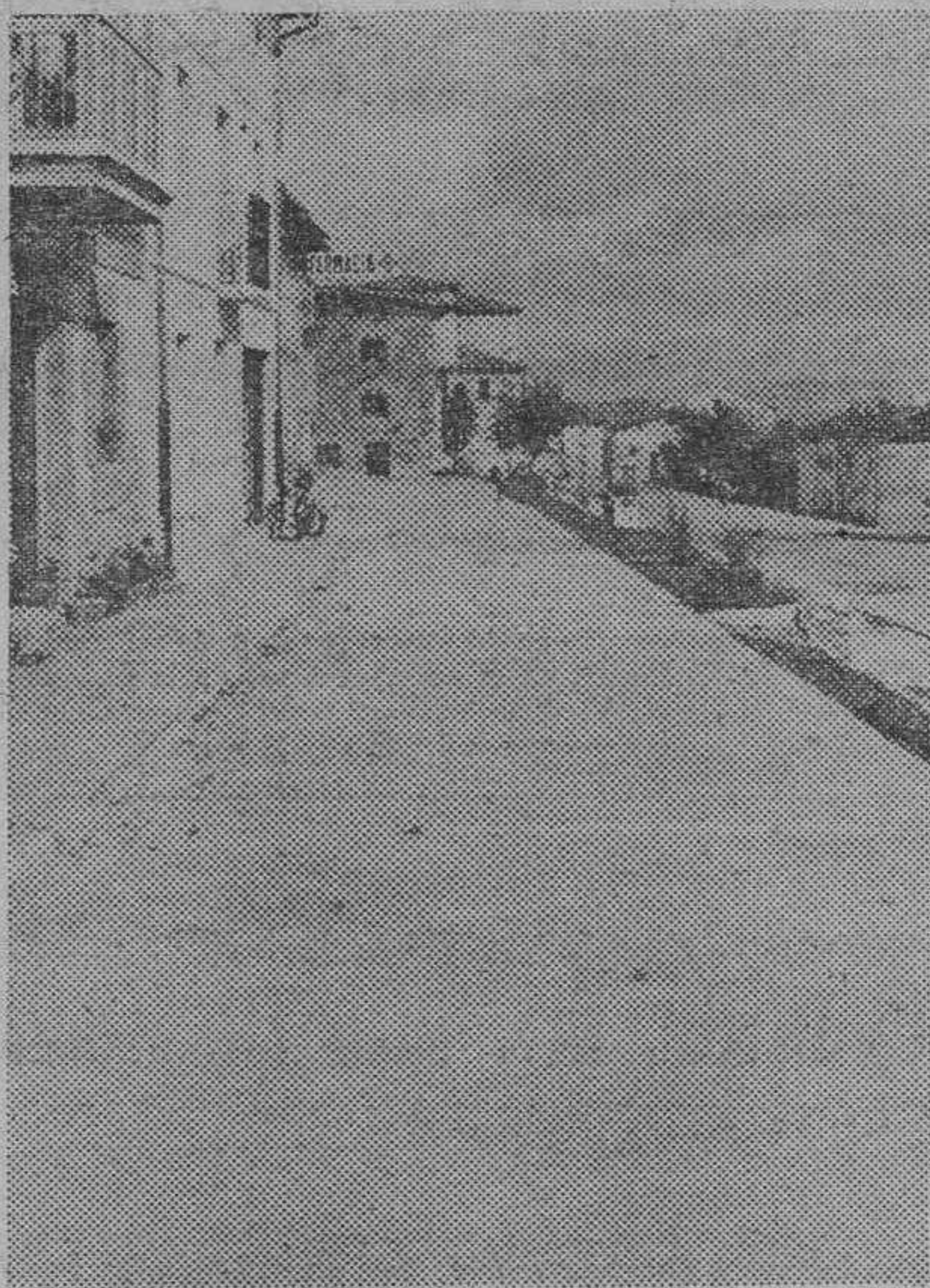
Un aspecto de las obras de mejora y urbanización llevadas a cabo en Villafranca Montes de Oca.
