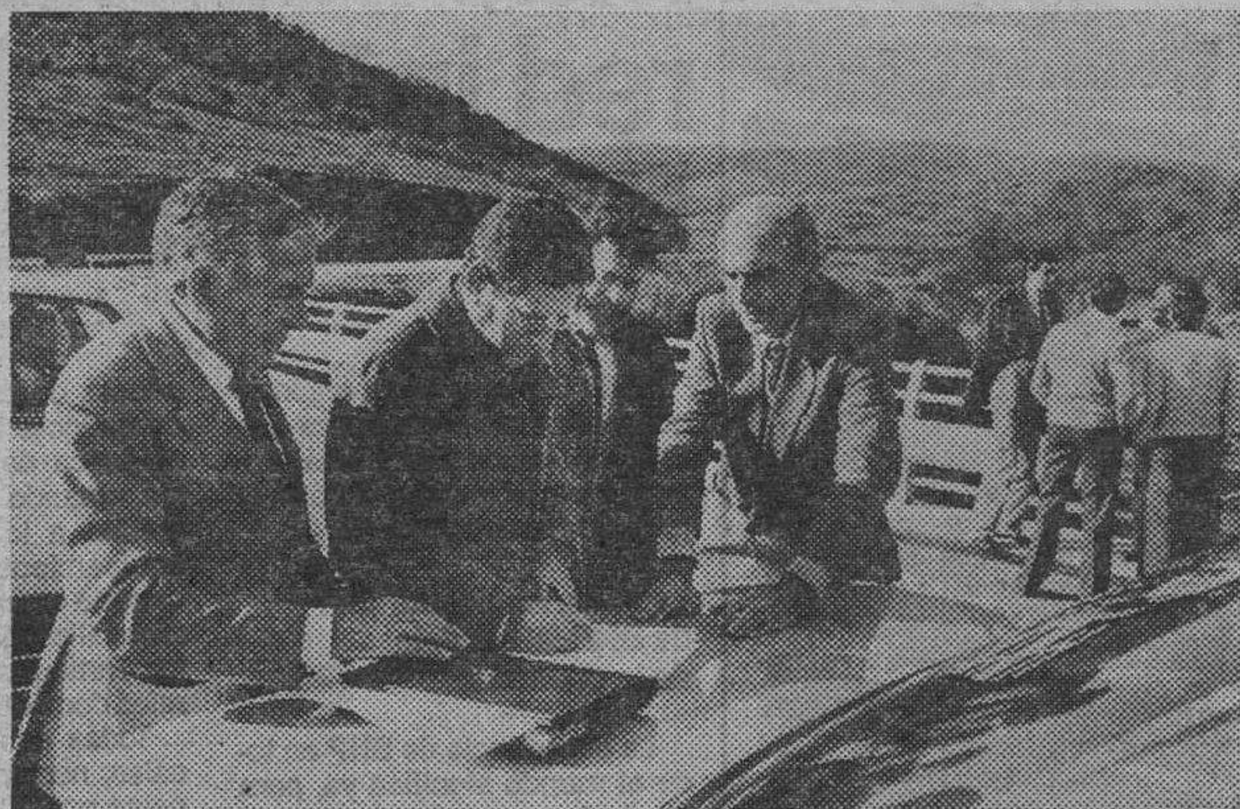
La construcción del segundo pantano del Arlanzón, obligó a modificar el trazado de la carretera provincial Ibeas-Pradoluengo con ramal a Pineda. La obra fue ejecutada por la Confederación Hidrográfica del Duero y el grabado recoge el momento de la firma, por el señor Montoya, del acta de recepción de los dos nuevos tramos de la vía provincial. (Foto FEDE)
