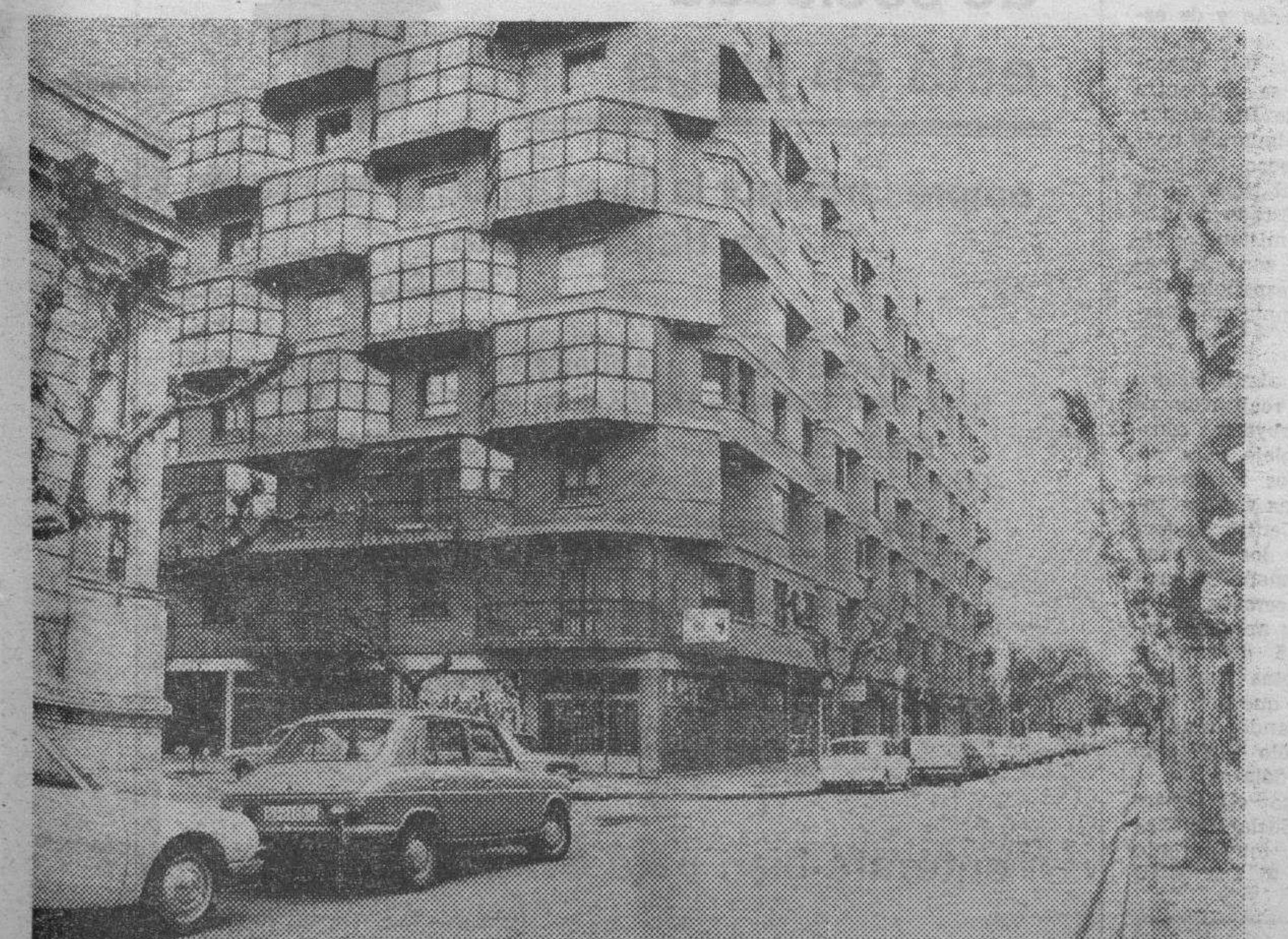
También a sorprendente transformación. La calle de Aparicio y Ruiz, desde donde desemboca la de Benito Gutiérrez, junto aparece en la siguiente foto, y que acoge actualmente a un buen número de viviendas y establecimientos comerciales de
