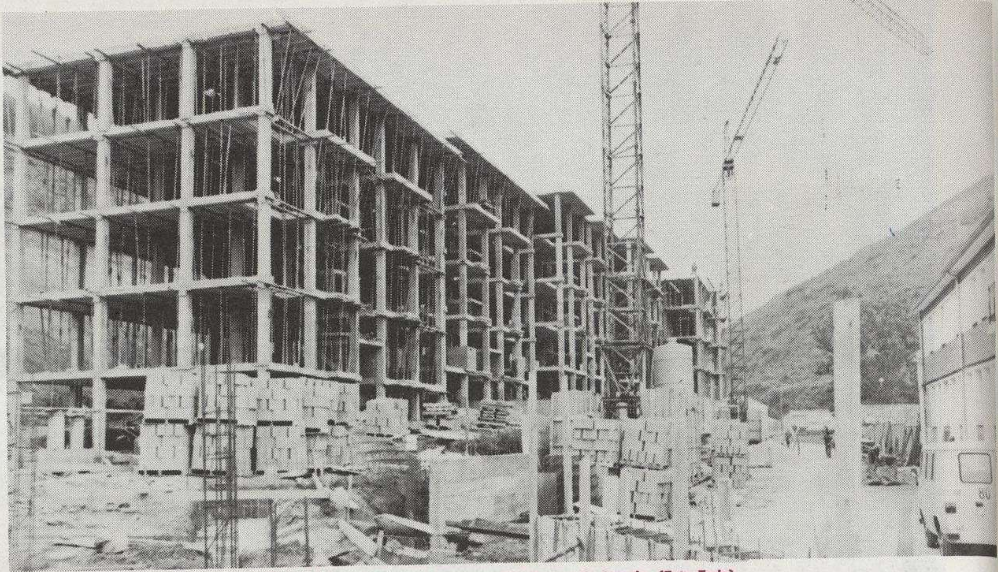
En Pradoluengo se está construyendo. Véase el ejemplo. (Foto Fede).
