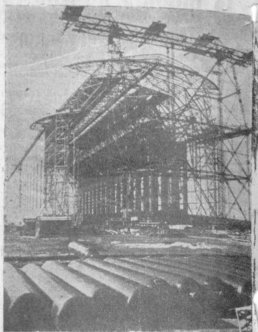
El esqueleto de un enorme hangar—el mayor del mundo—en el futuro aeropuerto de Francfort. En primer término, los tubos de hidrógeno para los dirigibles
