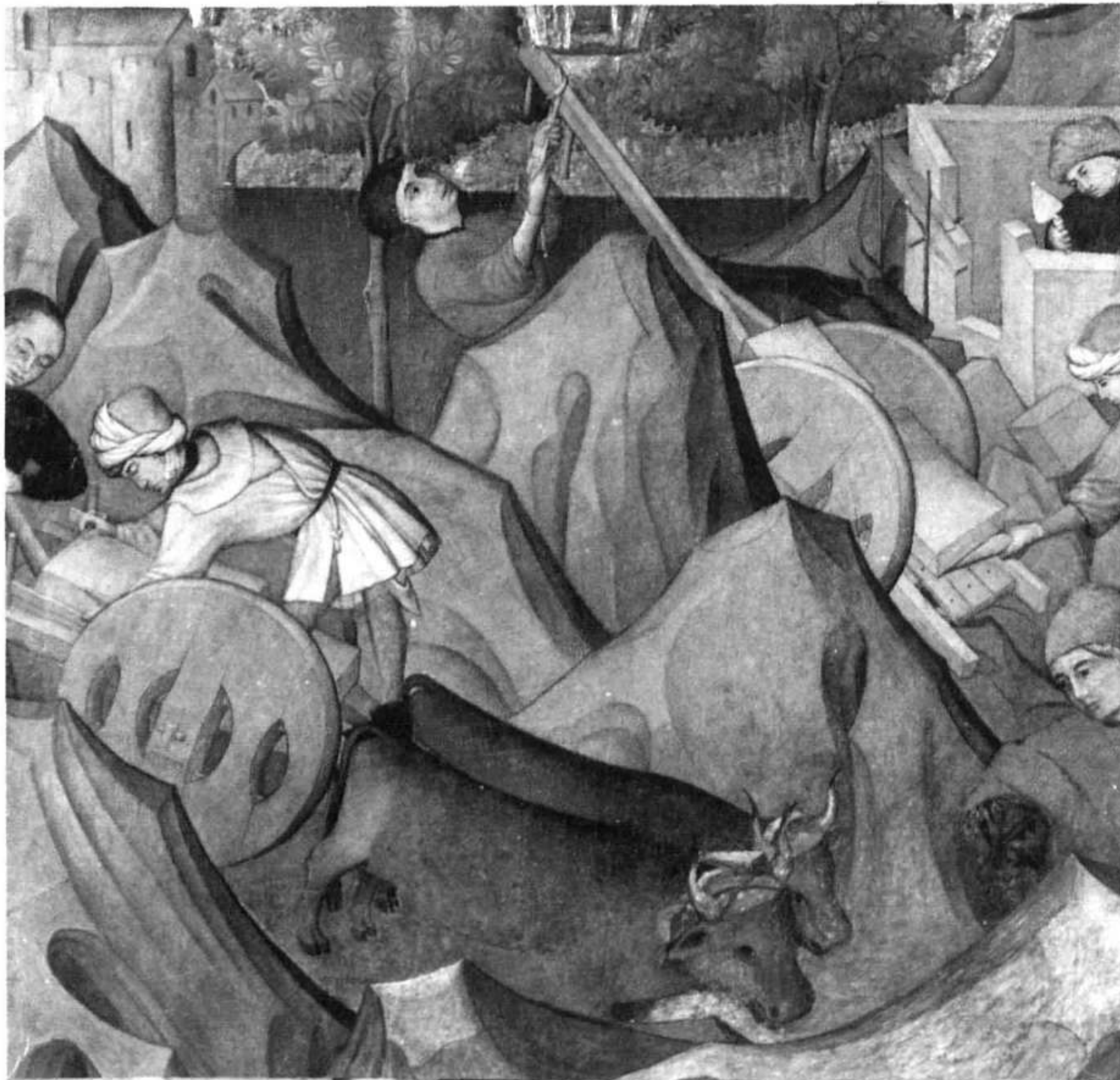
32.- Construcción de un edificio , de Nicolás Francés. Museo de Estocolmo. Fot. Arxiu Mas.
