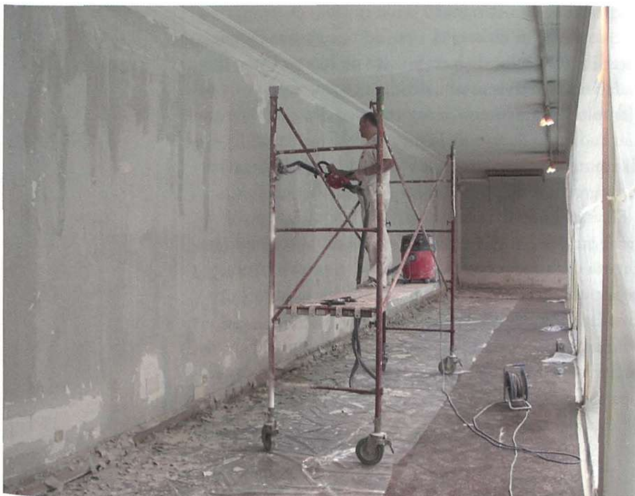
9. Obras de lijado de paredes provistas de aspirador que evita la propagación de residuos.
