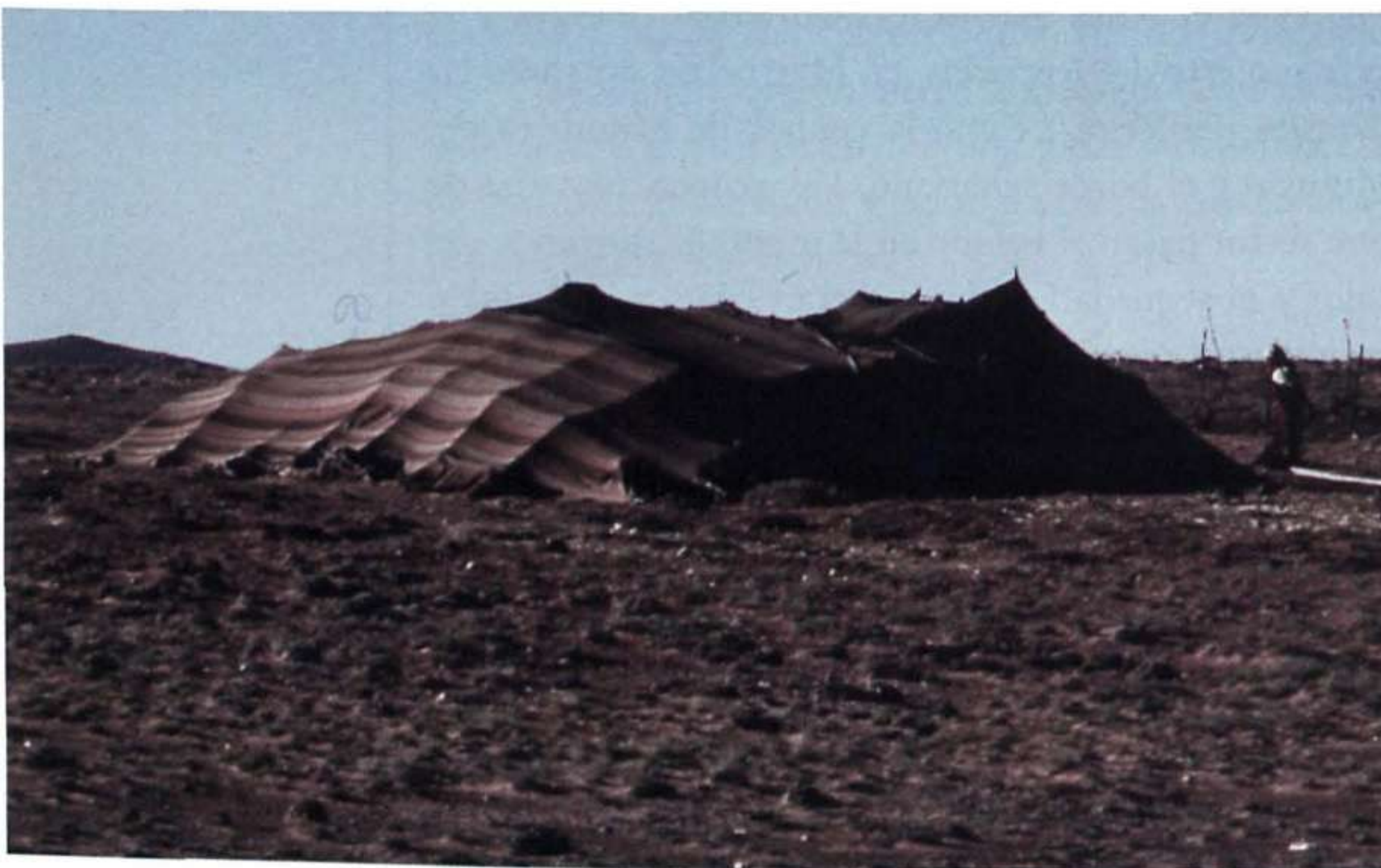
Fig. 5 - Gran tienda de las altas mesetas argelinas, entre Tismoulkine y El Bayadh. Al ser la tienda tan grande se necesita más de una fila de puntales maestros, lo que ocasiona que la tienda tenga más de un punto culminante.
