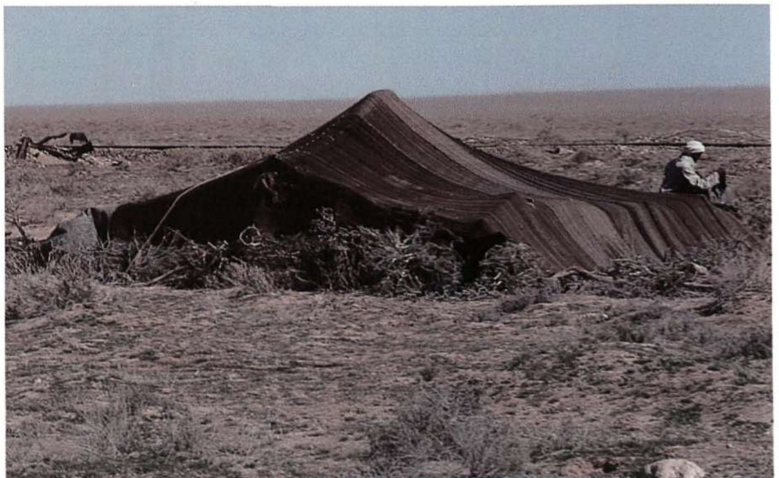
Fig. 6 - Tienda de la llanura de Gafsa (Túnez). Obsérvese como la cubierta cae por encima de los vientos.
