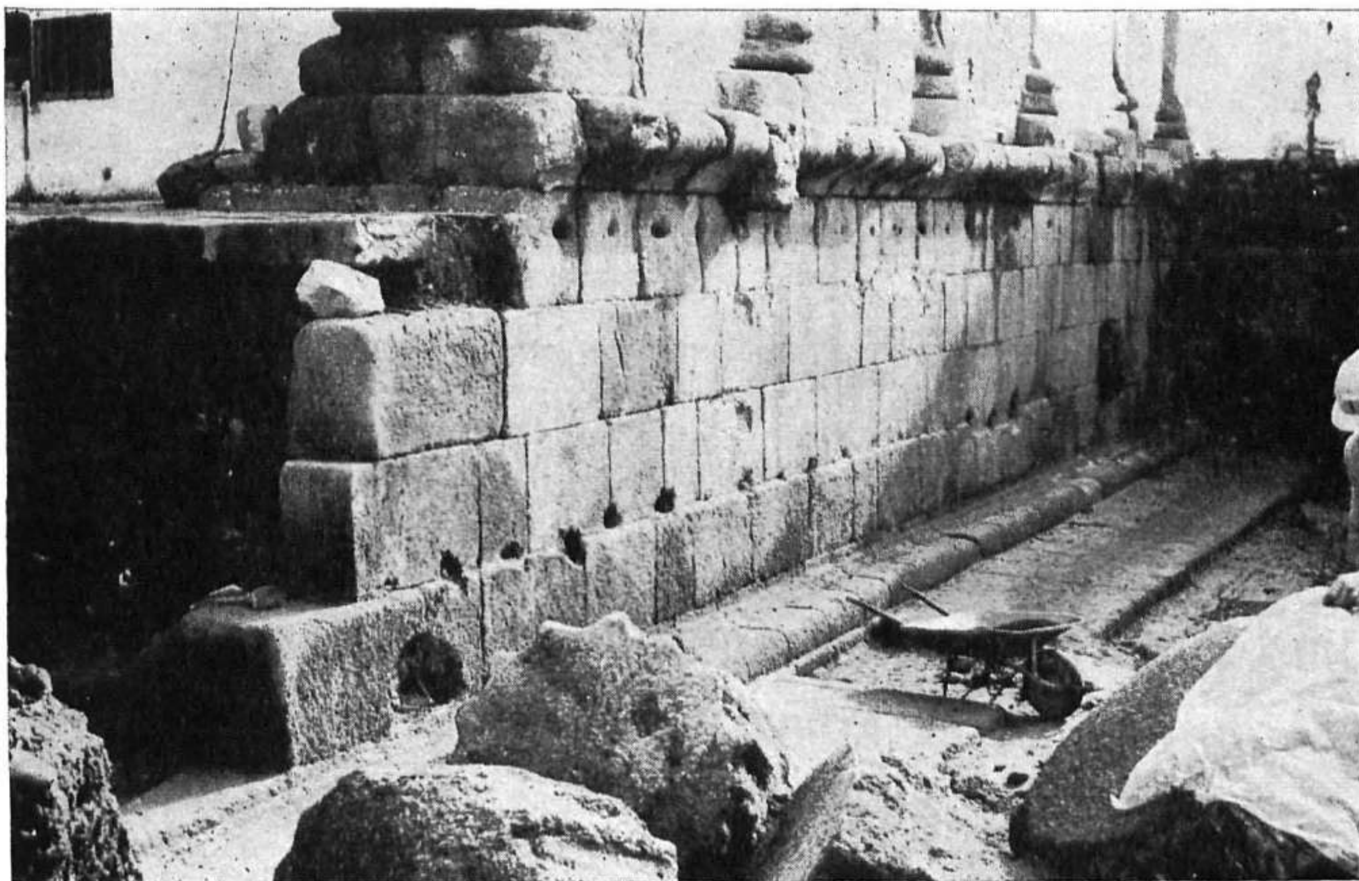
Lám. I.—Detalle del podium de la fachada occidental del «Templo de Diana» (Mérida).
