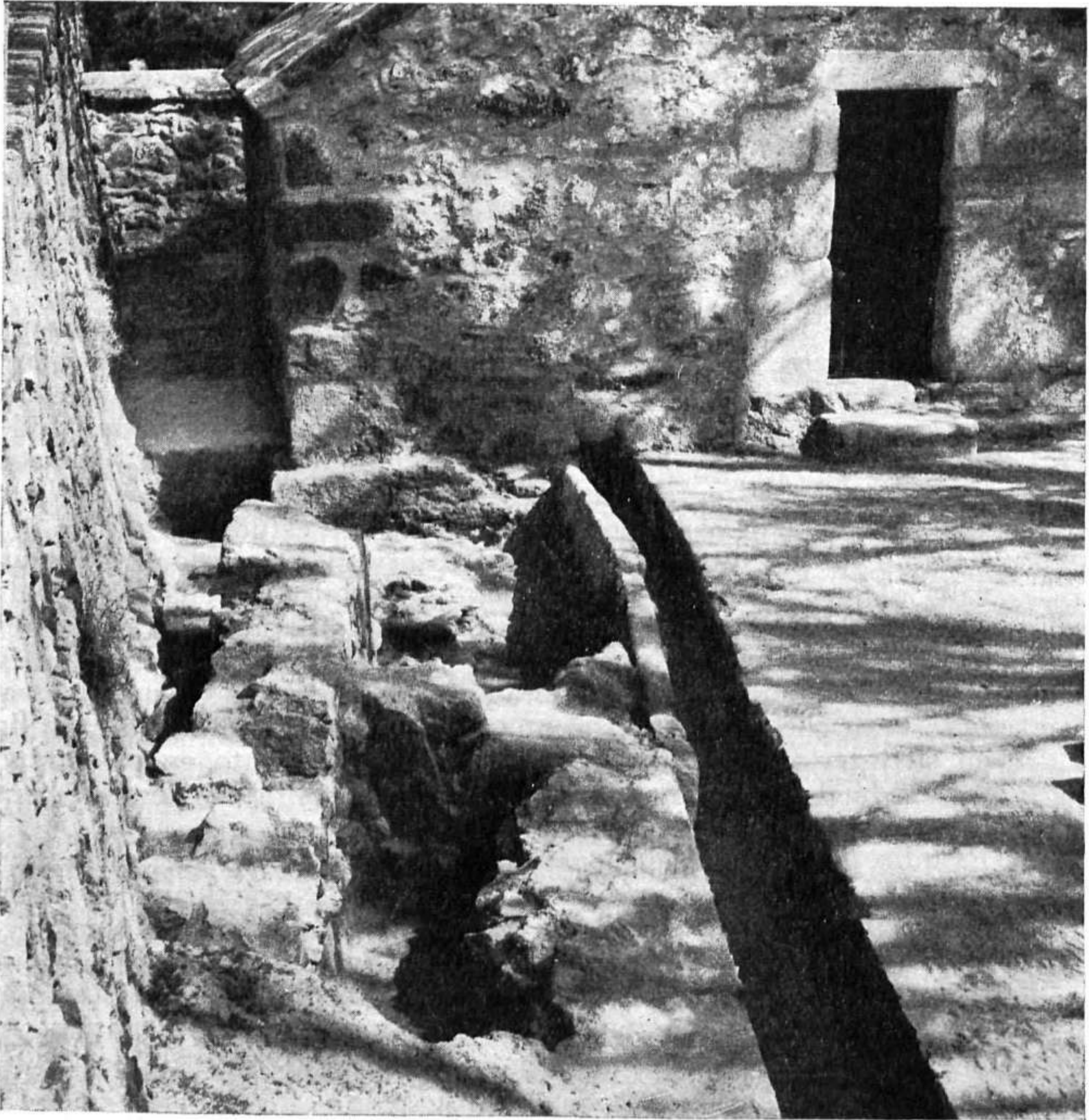
Lám. I.—Acueducto de Segovia. Vista general de la primera torre del agua, con los cimientos de la primitiva torre y del «speculum» antiguo.
