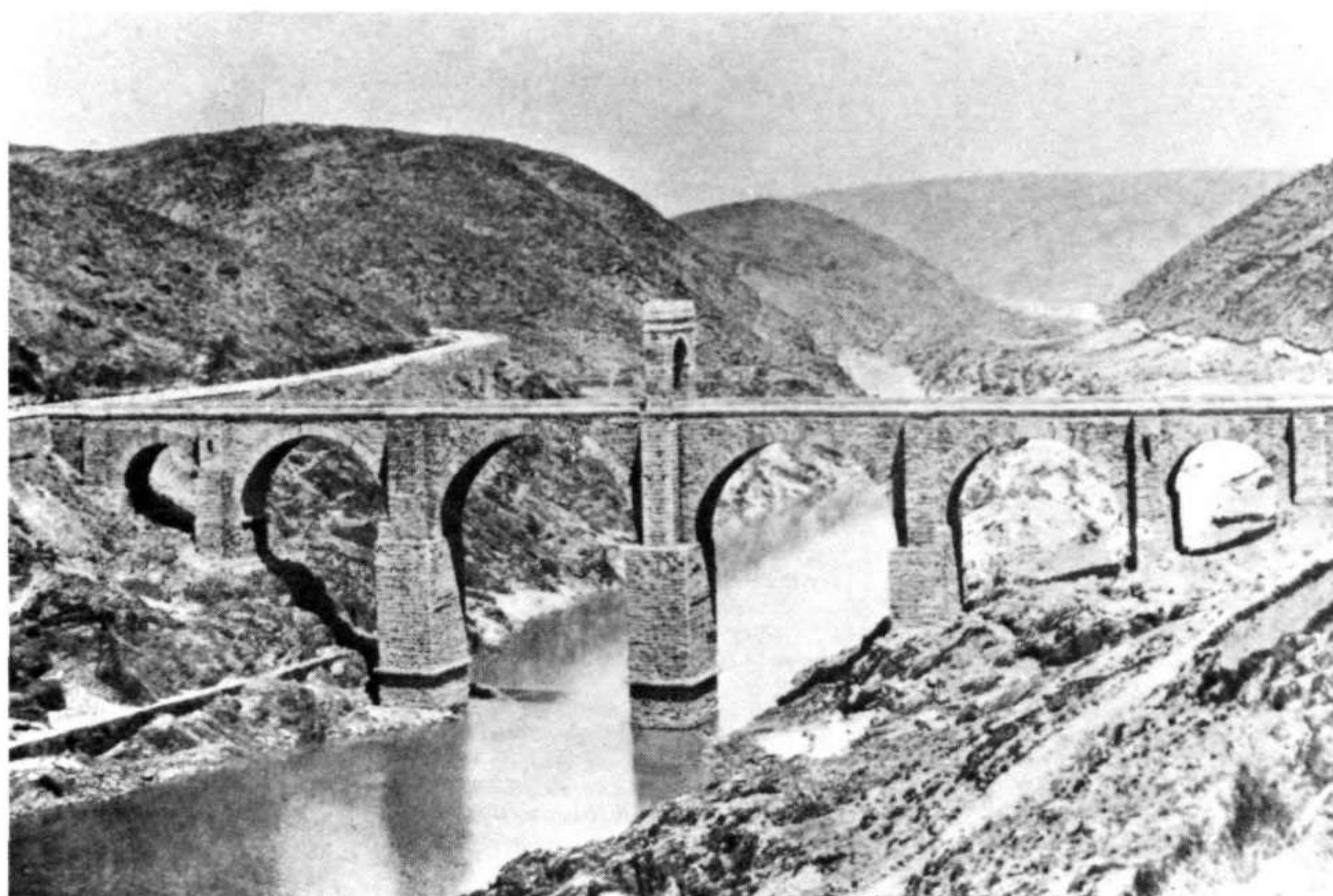
PUENTE DE ALCANTARA (CACERES), OBRA DE C. JULIUS LACER.
